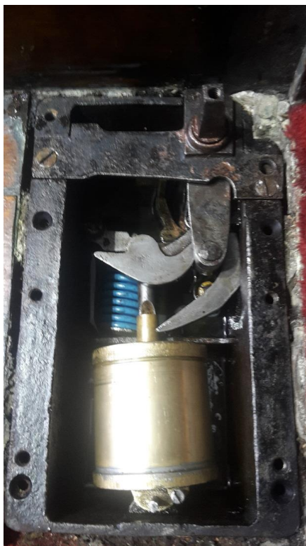
Slika 3.1: Jednoradna podna opruga za zatvaranje vrata [7]
