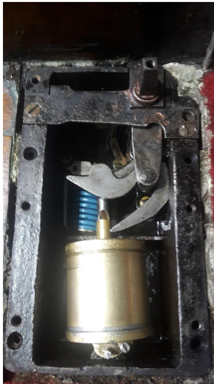
Slika 3.1: Jednoradna podna opruga za zatvaranje vrata [7]
