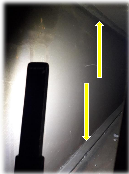
Slika 31. Dodavanje flaha i vizualna kontrola zavara [4]
