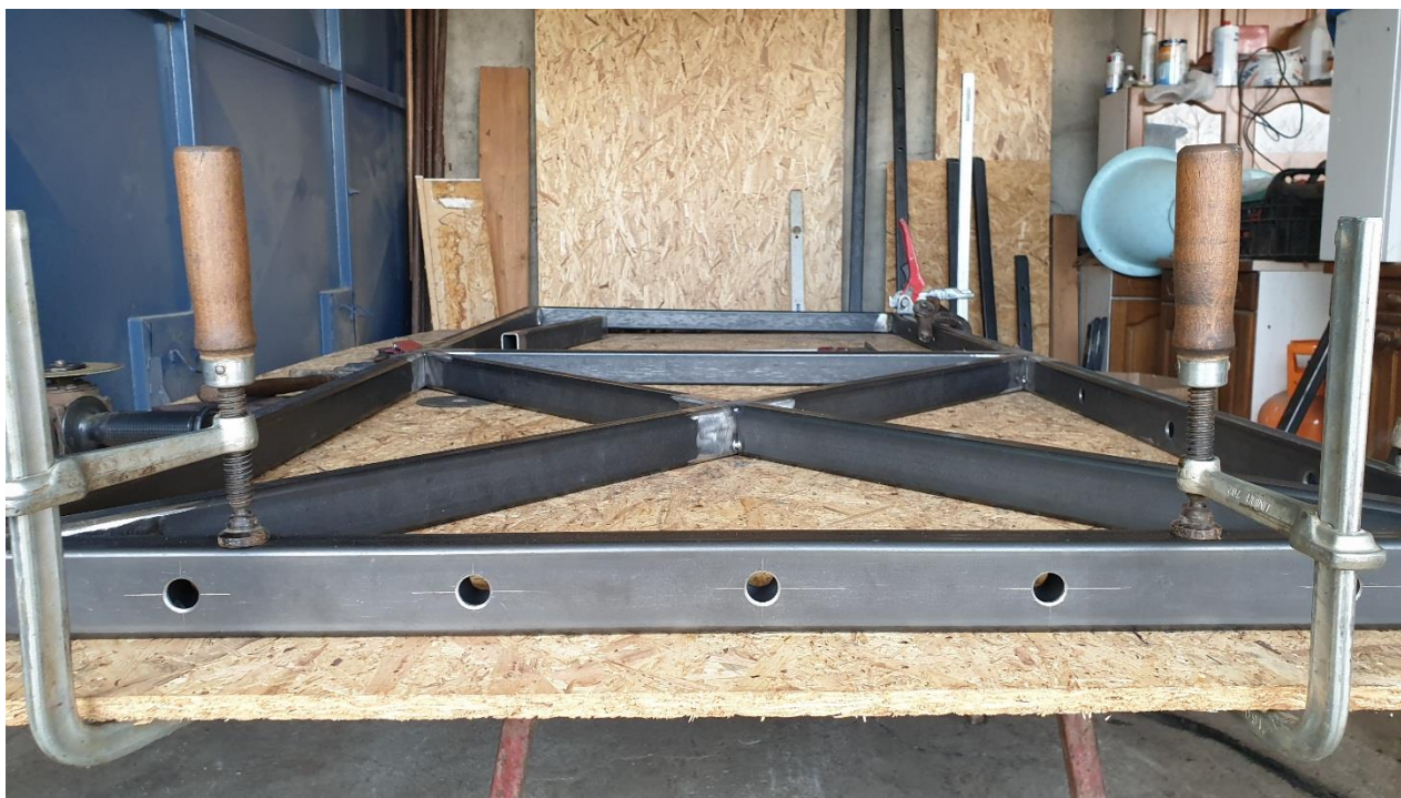
Slika 72. Zavarivanje nosive konstrukcije
