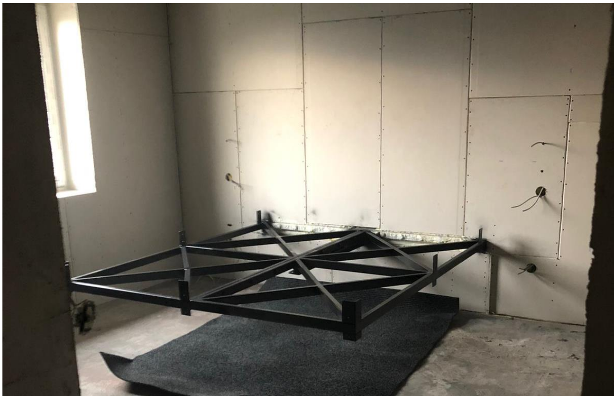
Slika 84. Antikorozivna zaštita nosive konstrukcije
