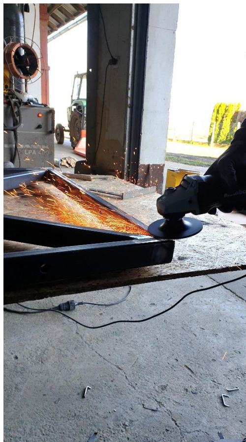
Slika 76. Brušenje zavora na čeonim spojevima
