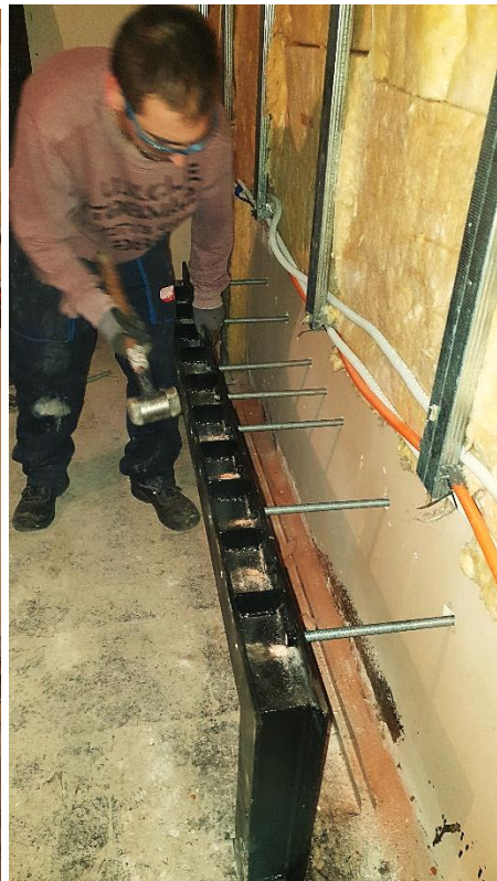
Slika 79. Fiksiranje konzolne potpore u zid
