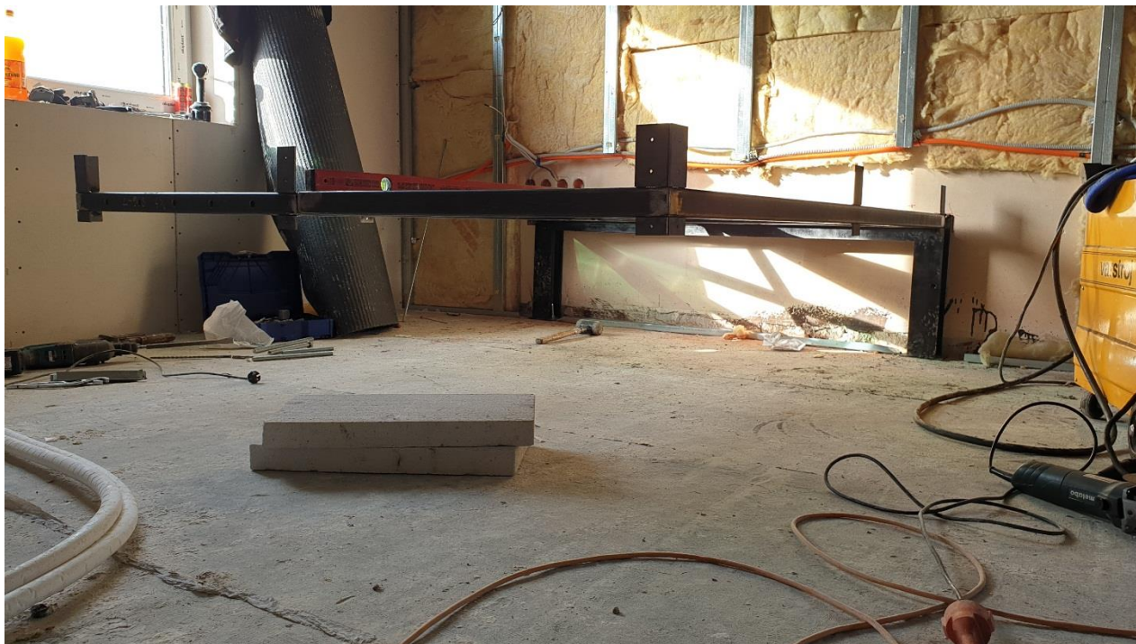
Slika 82. Završetak montaže nosive konstrukcije i konzolne potpore (2)
