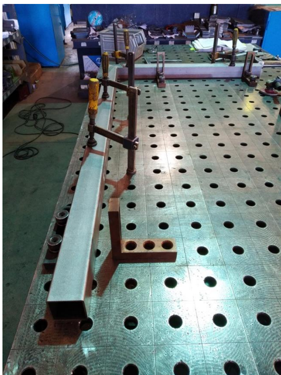
Slika 3.3. Bravarska montaža konstrukcije
