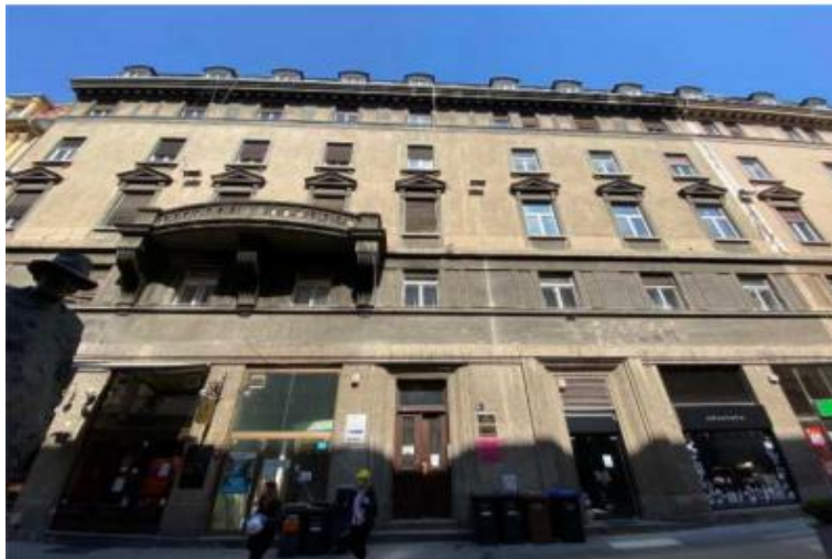
Slika 4.3. - Građevina za dijagnostiku i sanaciju
