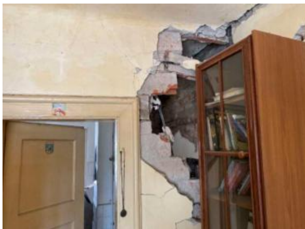
Slika 5.18. - Pregradni poprečni zid (istok-zapad)
