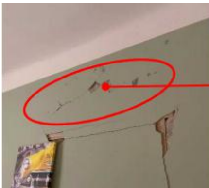
Slika 5.38. - Dijagonalne pukotina iznad zatvorenog otvora u pregradnom zidu
