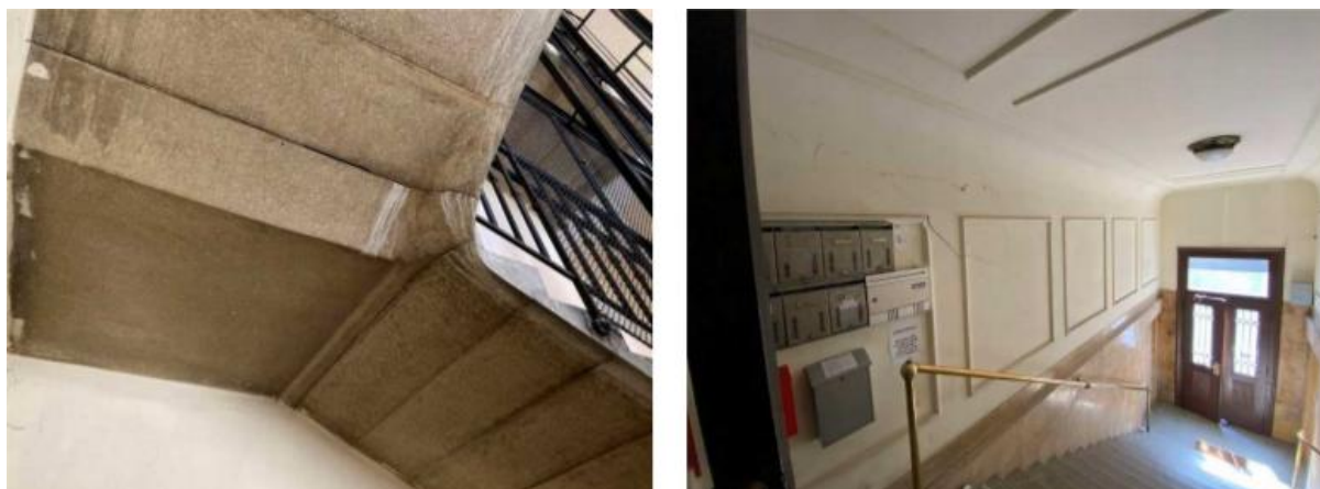
Slika 5.52. - Pogled na polupodest stubišta (lijevo) te ulazno stubište sa glavnog ulaza
