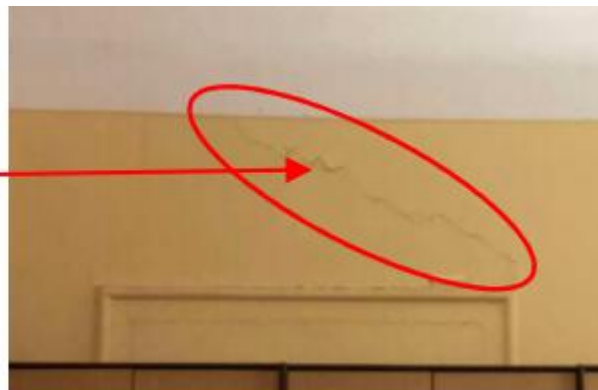
Slika 5.38. - Dijagonalne pukotina iznad zatvorenog otvora u pregradnom zidu
