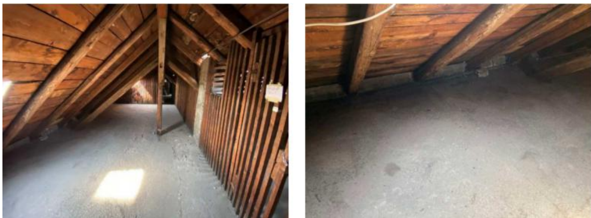
Slika 5.46. - Pogled prema zapadu na sustav krovišta
