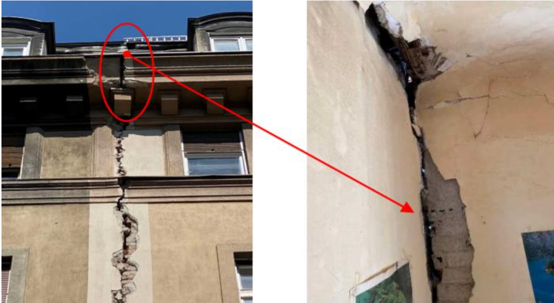
Slika 5.17. - Pogled na jugoistočni kut stana ali i cijele zgrade
