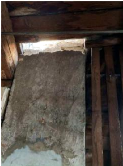
Slika 5.49. - Pogled iz tavanskog prostora na urušene dimnjake
