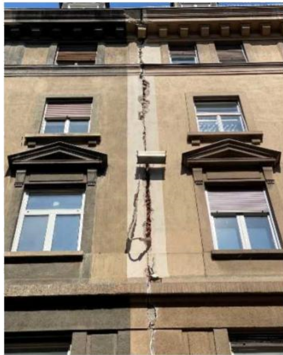
Slika 5.58. - Pogled na vertikalnu istočnu pukotinu
