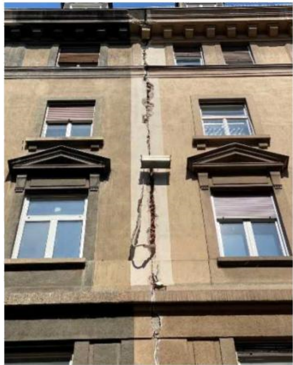
Slika 5.58. - Pogled na vertikalnu istočnu pukotinu
