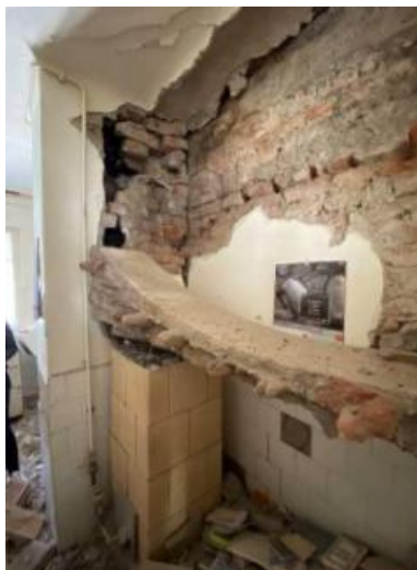
Slika 5.15. - Pogled uzduž krajnjeg istočnog nosivog zida
