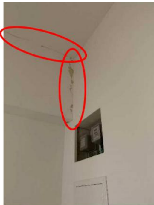
Slika 5.33. - Vertikalne pukotine zidnih gipskartonskih obloga
