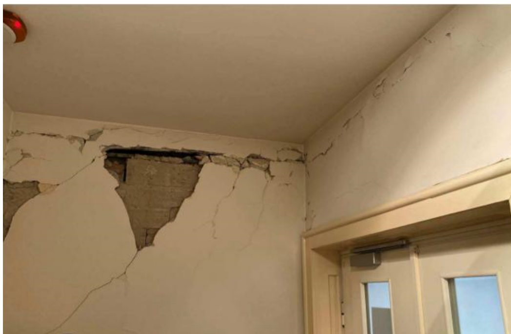
Slika 5.10. - Ulaz u predmetni stan, pogled na pregradni zid koji se naslanja na unutarnji nosivi zid
