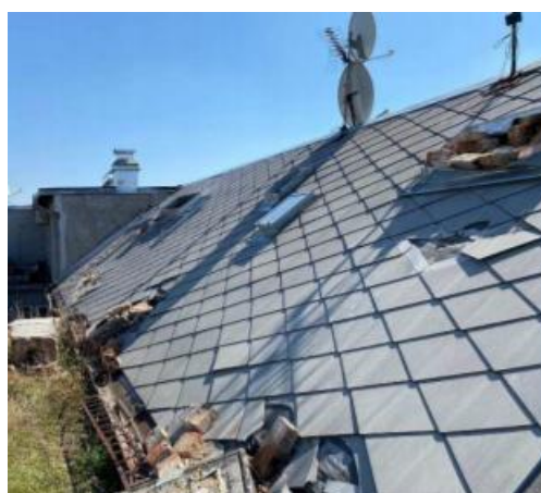
Slika 5.48. - Pogled prema istočnom dijelu krovišta
