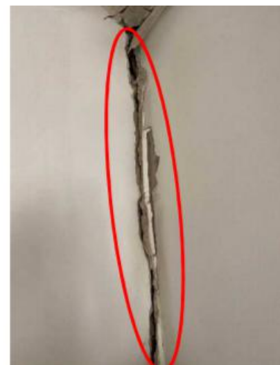
Slika 5.23. - Dijagonalne pukotine na istočnom zidu, vertikalno pukotinsko oštećenje jugoistočnog kuta zgrade (desno)
