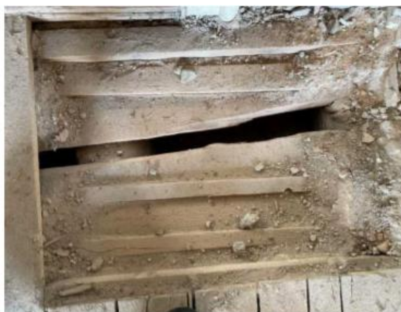
Slika 5.21. - Ručno izvedena oštećenja na zidu i podnoj konstrukciji
