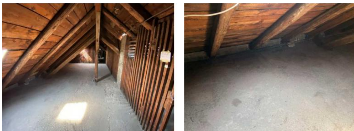
Slika 5.46. - Pogled prema zapadu na sustav krovišta
