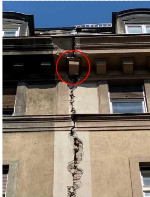
Slika 5.59. - Pogled na oštećeni estetski fasadni element kojeg je hitno potrebno ukloniti radi sveopće sigurnosti ljudi
