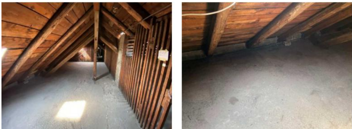
Slika 5.46. - Pogled prema zapadu na sustav krovišta
