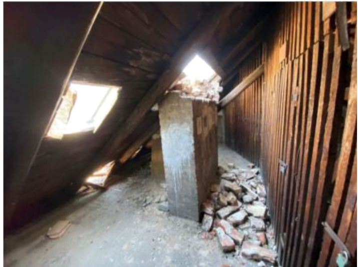
Slika 5.49. - Pogled iz tavanskog prostora na urušene dimnjake
