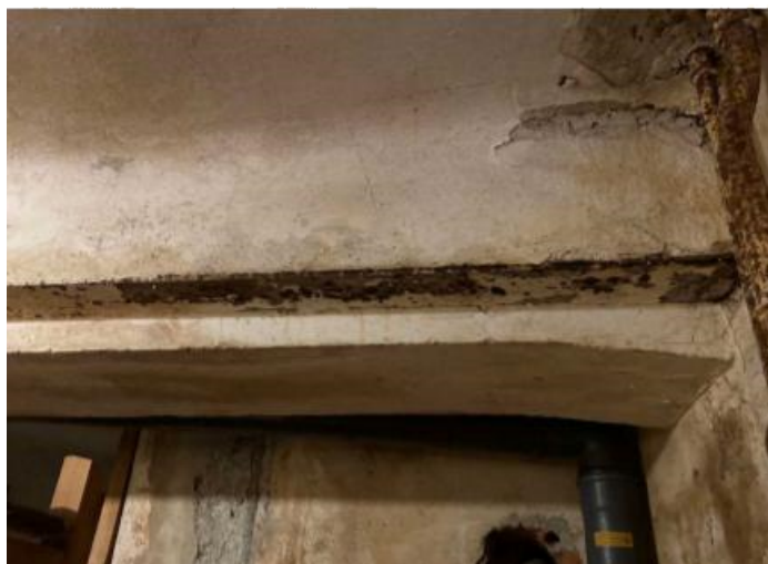
Slika 5.56. - Vidljivi I-profili u stropnom sustavu podruma na pravilnom razmaku između lučnih betonskih svodova
