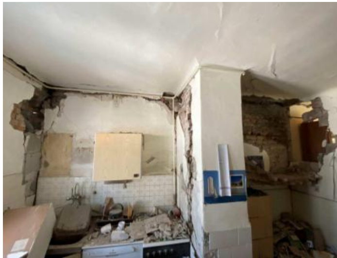
Slika 5.13. - Pogled na krajnji nosivi istočni zid zgrade
