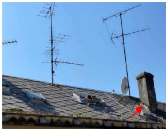
Slika 5.47. - Urušeni dimnjaci na krovu zgrade
