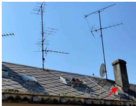
Slika 5.47. - Urušeni dimnjaci na krovu zgrade
