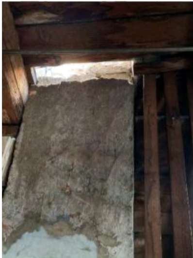
Slika 5.49. - Pogled iz tavanskog prostora na urušene dimnjake
