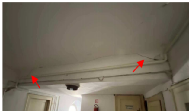
Slika 5.50. - IV. kat stubišta
