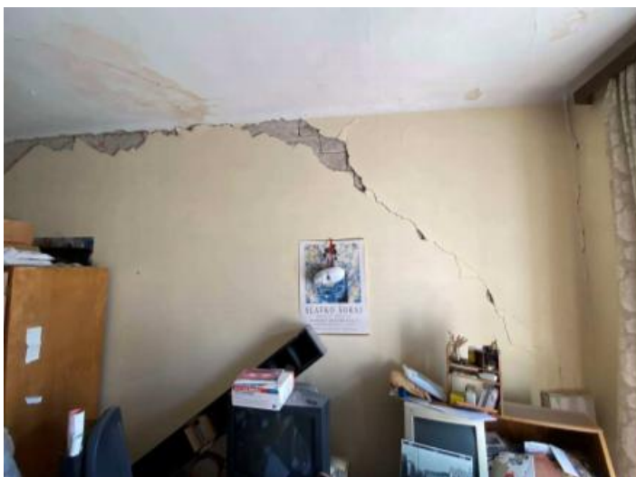
Slika 5.23. - Dijagonalne pukotine na istočnom zidu, vertikalno pukotinsko oštećenje jugoistočnog kuta zgrade (desno)
