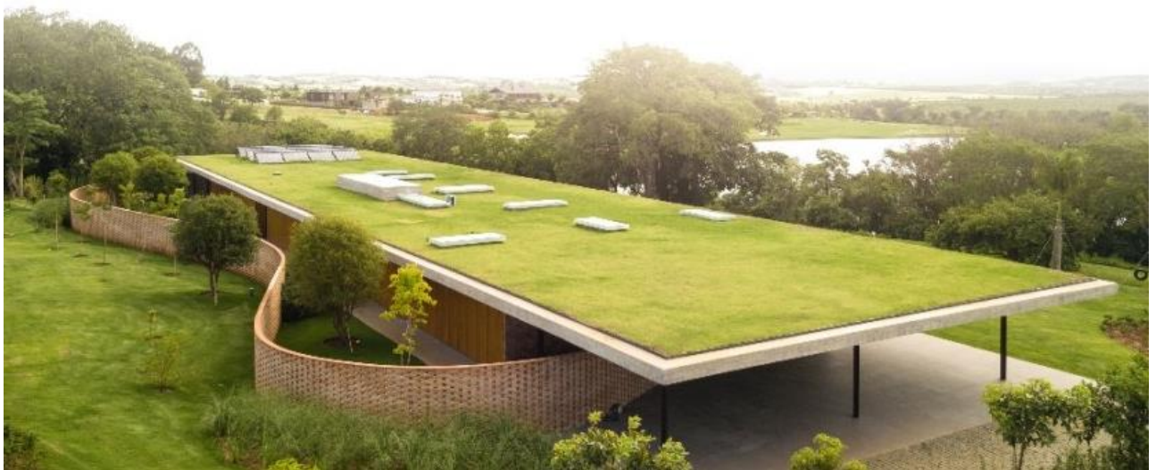
Slika 18. Ekstenzivni zeleni krov
