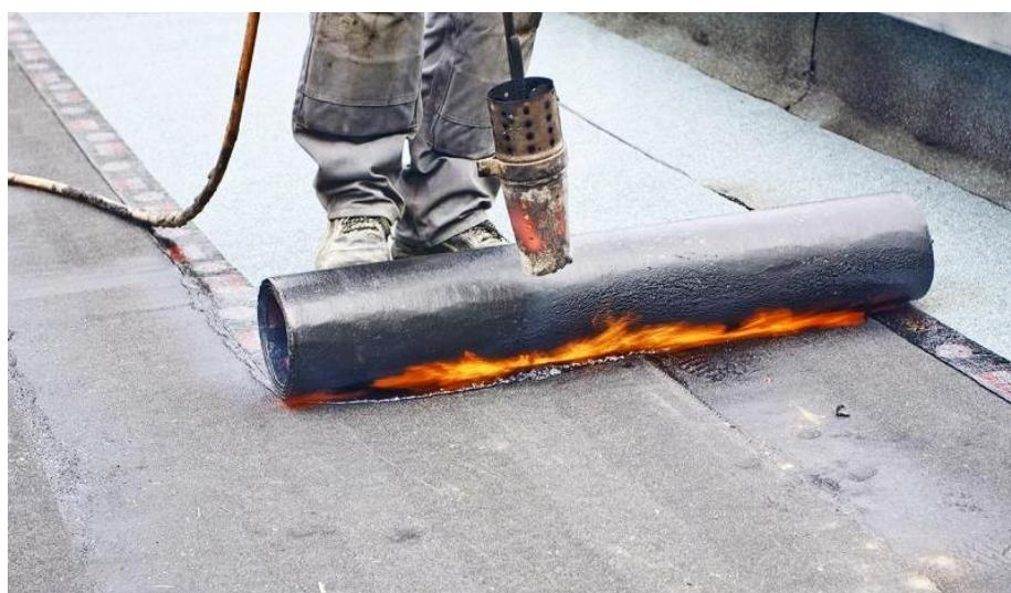
*Slika 3. Postupak postavljanja bitumenske HI trake*
