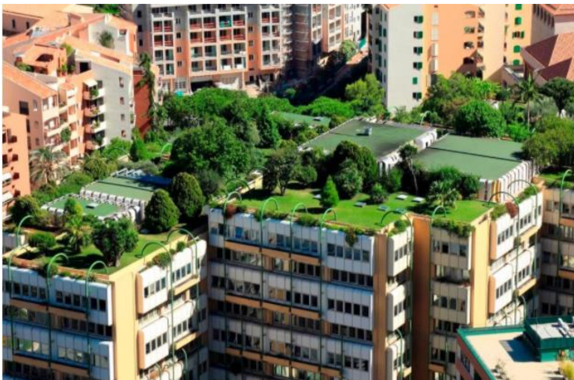
Slika 17. Intenzivni zeleni krov
