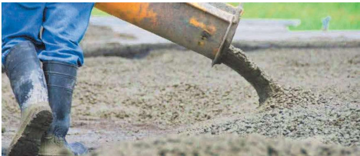
*Slika 4 - Betonski radovi, izljevanje betona za betonsku podnu ploču [Izvor: <https://www.gtr-mostar.com/betonski-radovi.php> ]*
