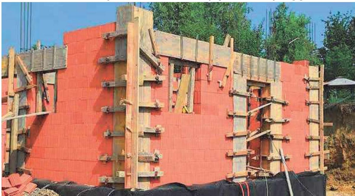
*Slika 6 - Tesarski radovi, postavljanje oplate za AB vertikalne serklaže i AB nadvoje [Izvor: <https://pravimajstor.hr/stupovi-i-nadvoji/> ]*
