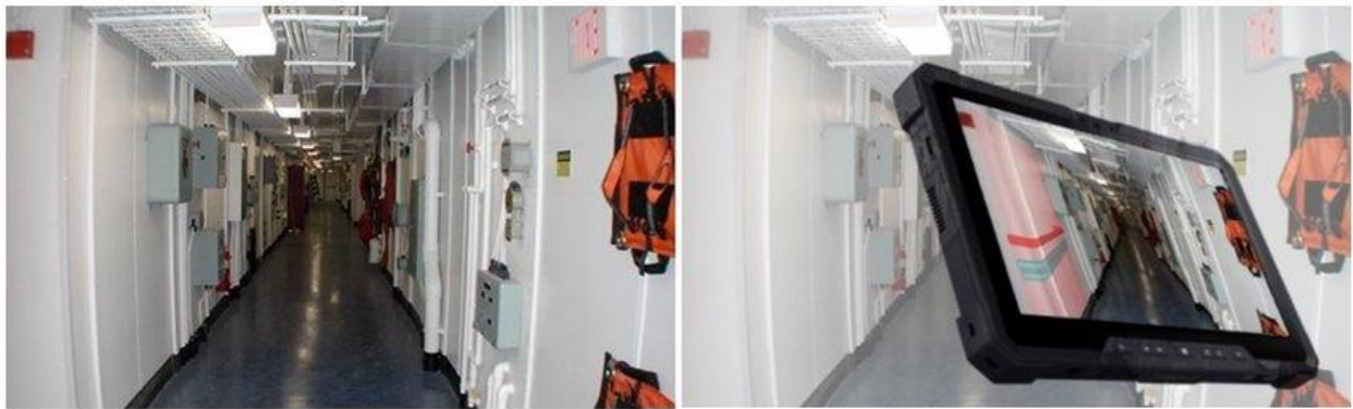
Slika 21 Operator koristi predloženi sustav za pregled instalacija koje su golim okom nevidljive u pogođenom području, odlučujući za spretniji i brži način popravljivanja
