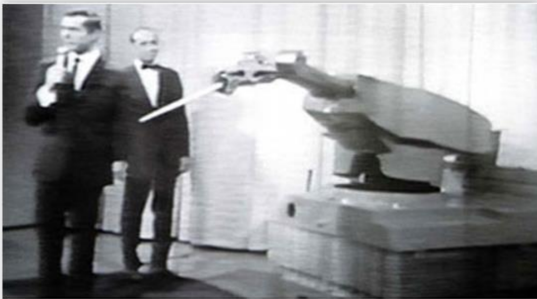
Slika 8. Unimate – prvi industrijski robot
