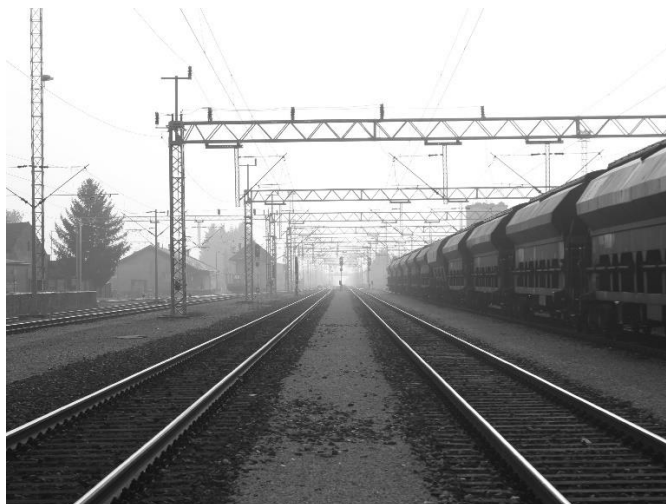
Slika 8.4.1. 37 Autor: Nikola Mišel Puklin, Željeznički kolodvor Koprivnica
