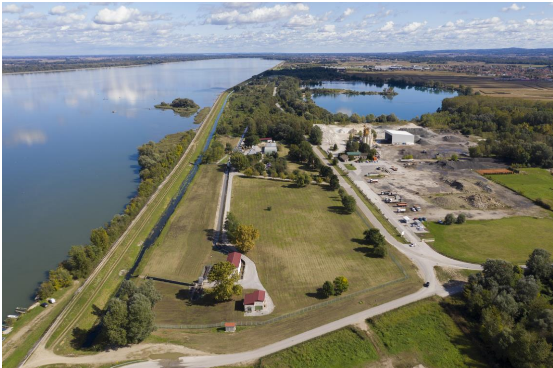
Slika 1.1. UPOV Varaždin – glavni kolektor, kišni preljev s prijamnikom, Crpna stanica, trapezni kanal
