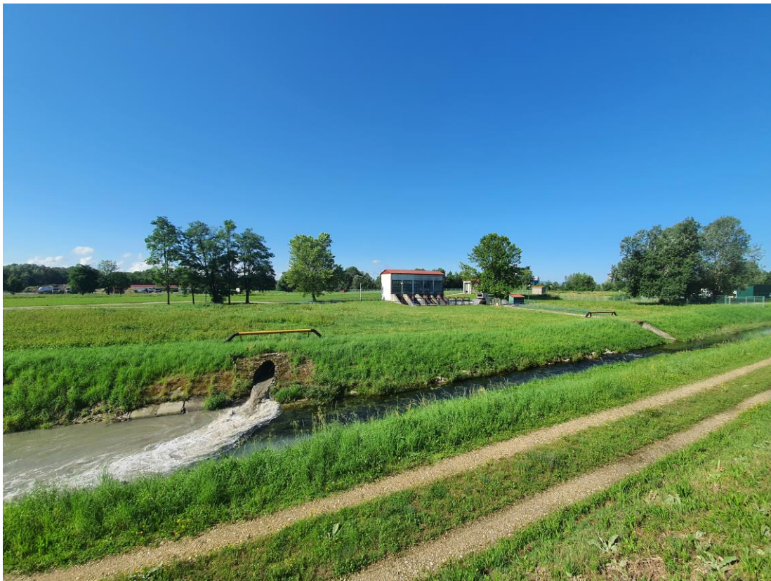
Slika 2.2. Kišni preljev ispred UPOV-a Varaždin (prelijevanje u recipijent nakon oborina 7.7.2020.)
