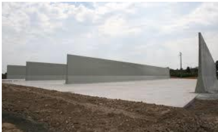
Slika 2.4: Vodoravni silos omeđen zidovima sa dvije strane (Izvor: http://www.aurora-invest.hr/ponuda/fattori/otvoreni-horizontalni-silos )
