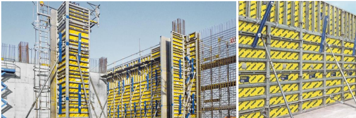
Slika 2.1. Zidna oplata Framax Xlife
