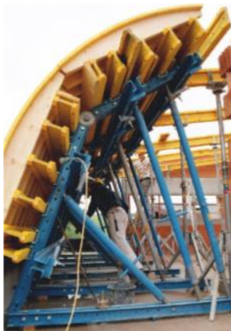
Slika 3.18. Rešetkasti nosivi element
