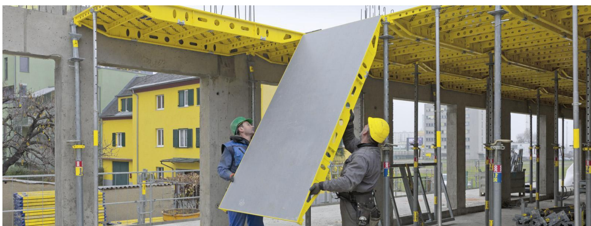
Slika 2.6. Stropna oplata Dokadek 30
