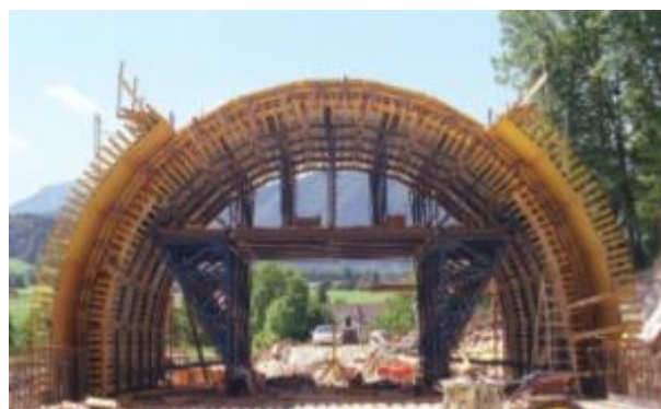
Slika 3.20. Primjena zglobne spojke A Top50
