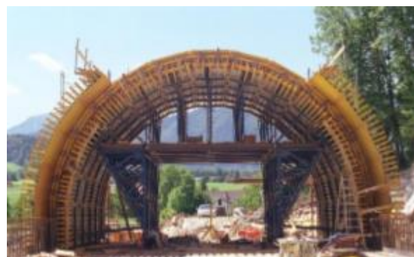
Slika 3.20. Primjena zglobne spojke A Top50
