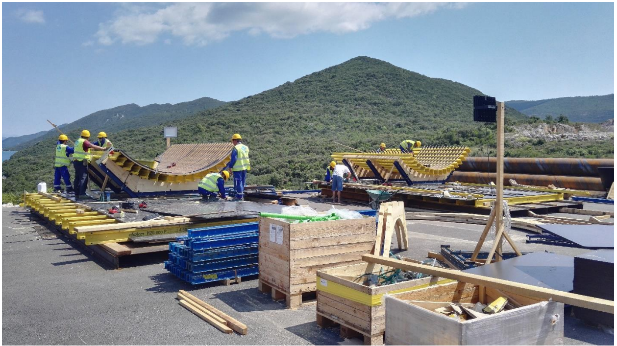
Slika 4.13. Predmontaža oplatnih elemenata
