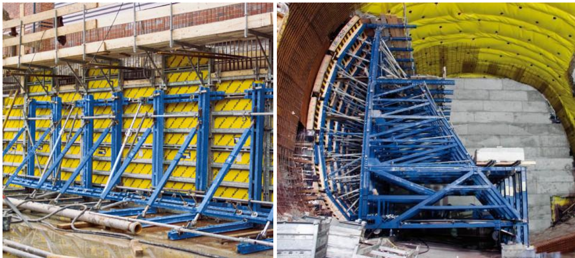
Slika 2.4. Podupirači jednostrane oplata
