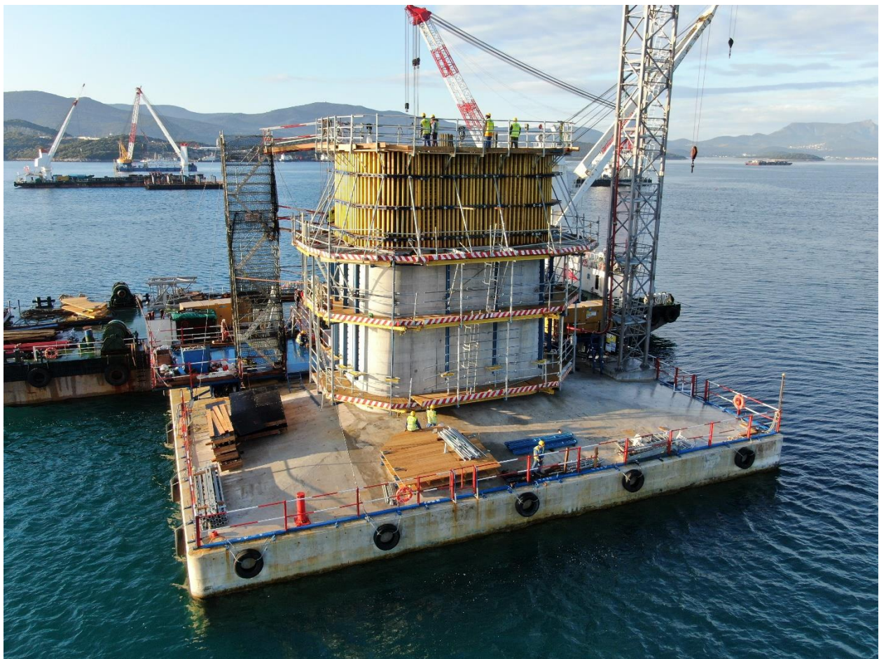
Slika 4.15. Oplata stupa
