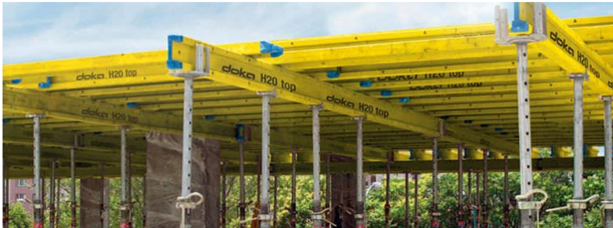
Slika 2.5. Stropna oplata Dokaflex
