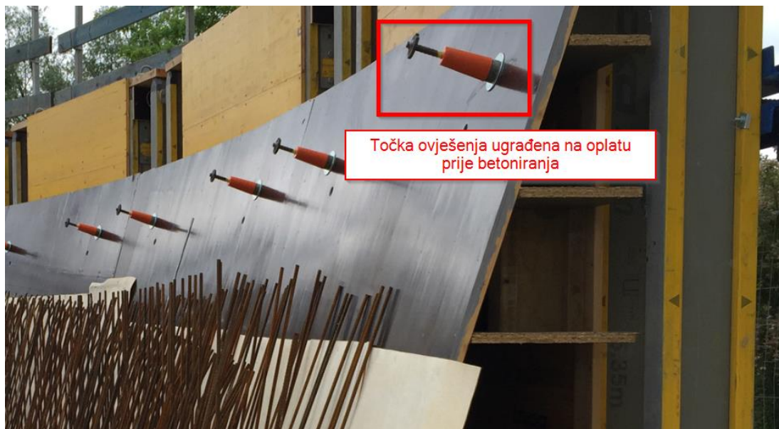
Slika 2.12. Penjajuća oplata i točka ovješnja
