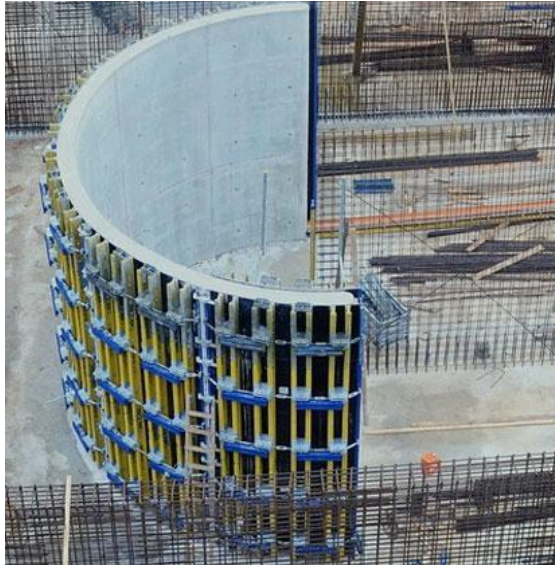
Slika 2.3. Kružna oplata H20
