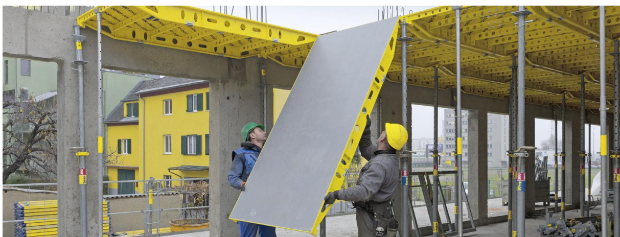
Slika 2.6. Stropna oplata Dokadek 30
