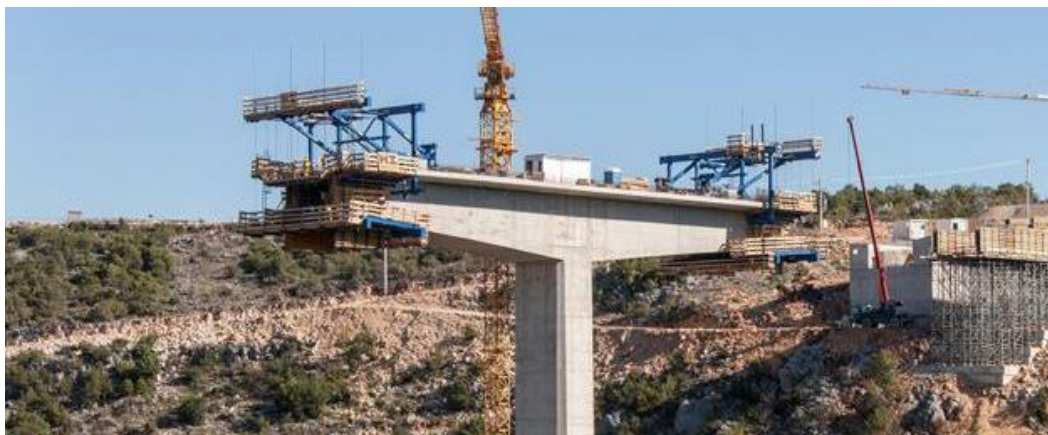
Slika 2.10. Krletka za konzolnu gradnju
