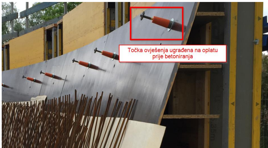
Slika 2.12. Penjajuća oplata i točka ovješnja
