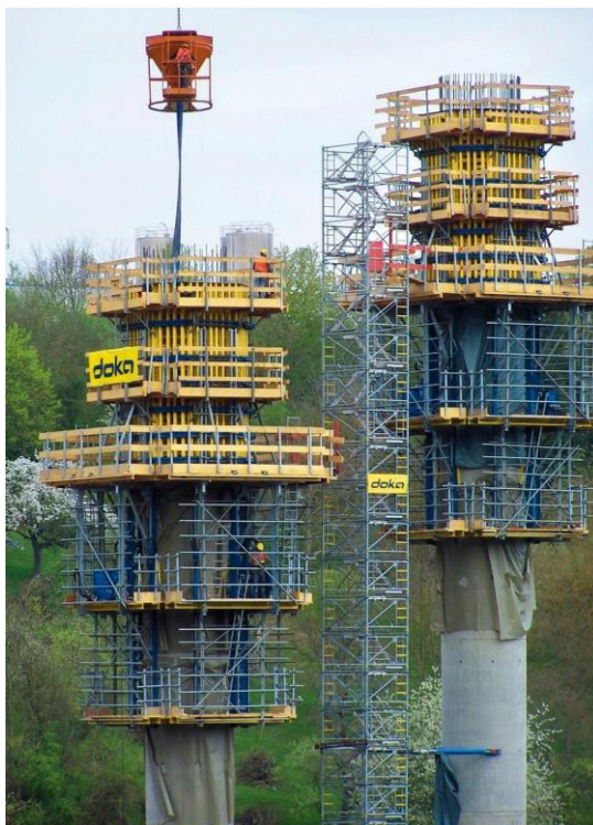
Slika 2.13. Penjajuća oplata Xclimb 60
