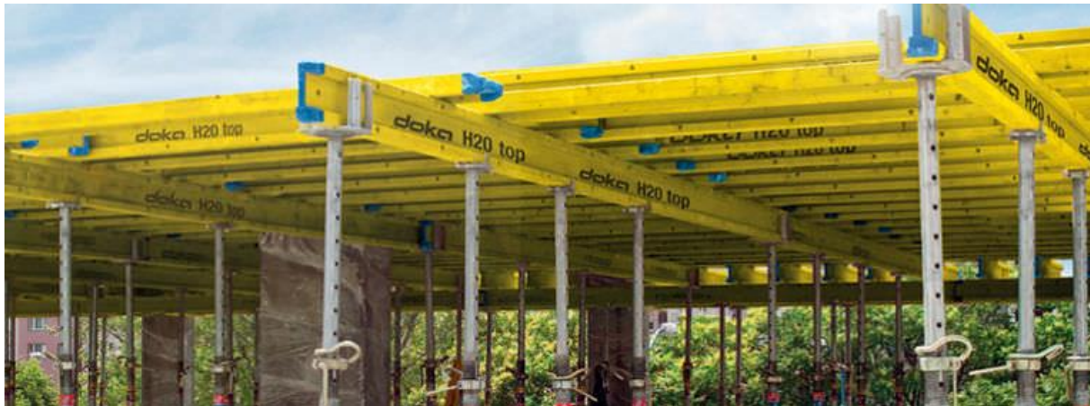
Slika 2.5. Stropna oplata Dokaflex
