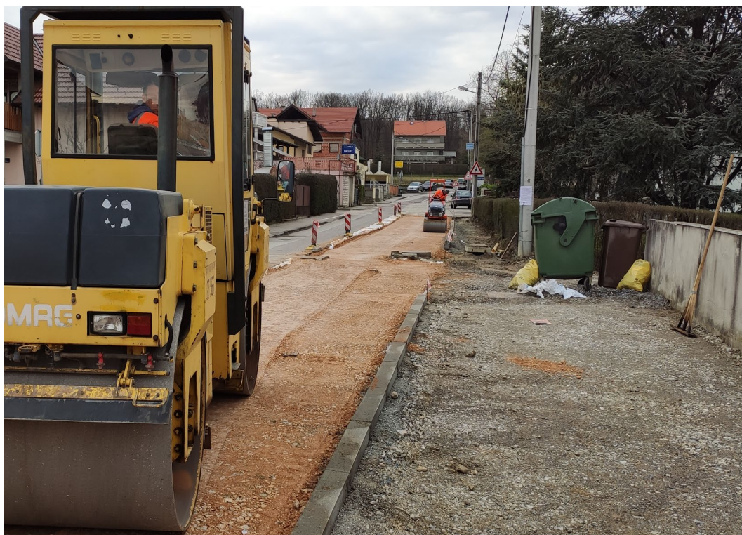
Slika 4.8 Zbijanje stabiliziranog kamenog materijala valjkom (vlastiti izvor)
