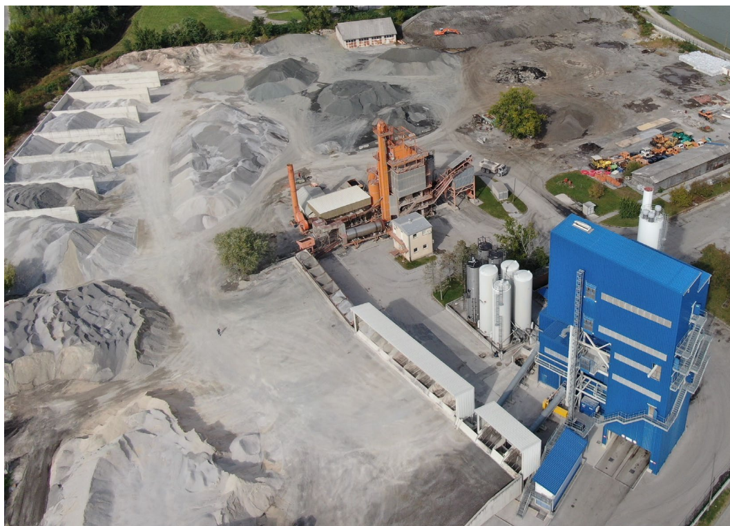
Slika 2.2 Asfaltna baza Rakitje (vlastiti izvor)
