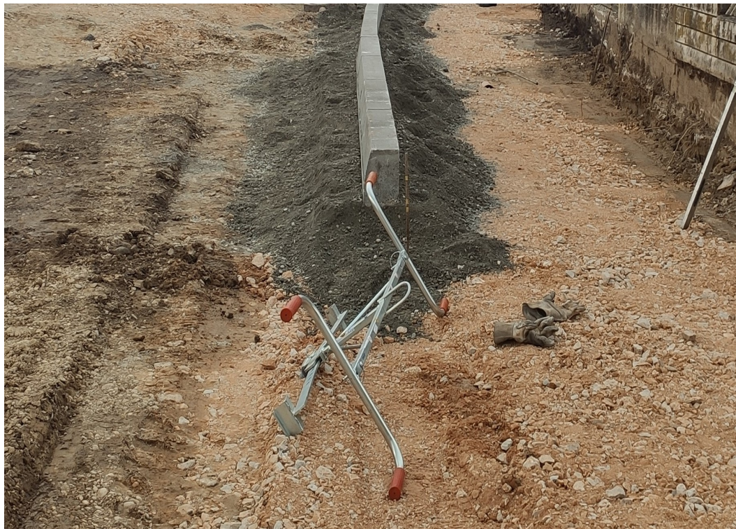
Slika 4.4 Postavljanje betonskih rubnjaka (vlastiti izvor)
