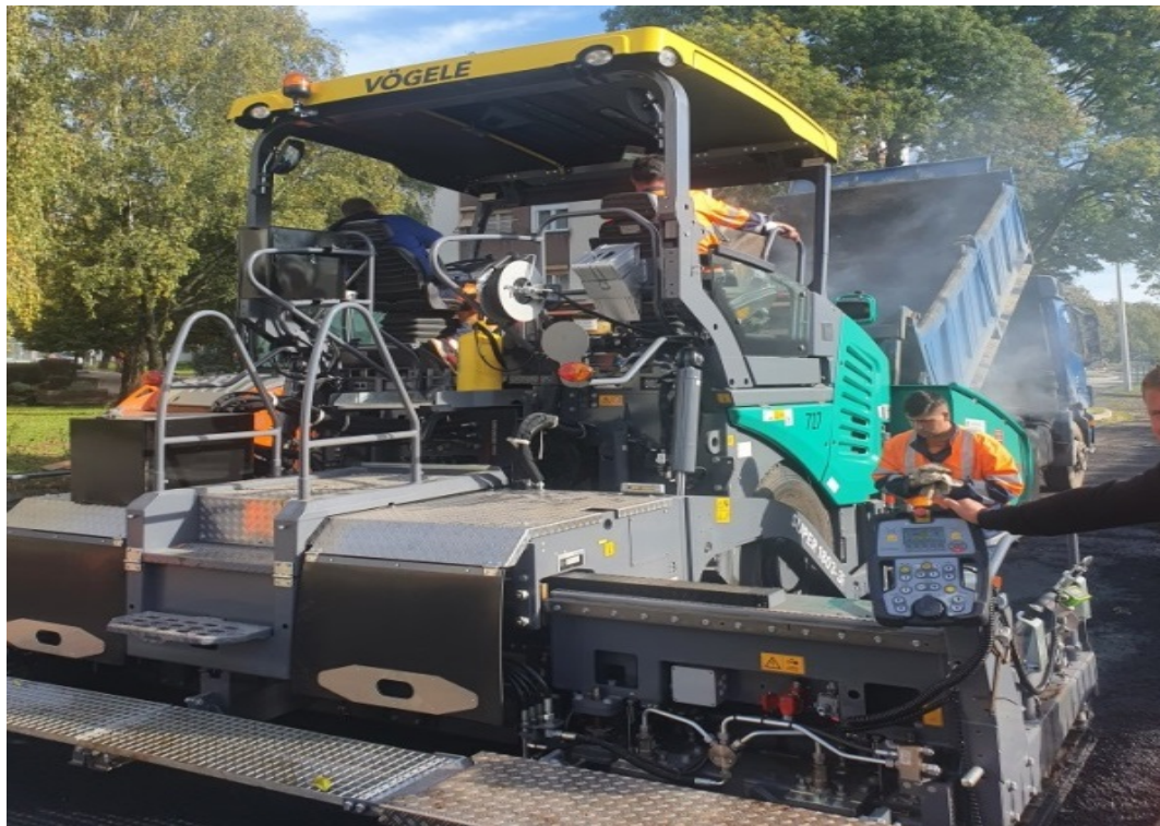
Slika 4.9 Ugradnja asfaltne mješavine AC 11 surf (vlastiti izvor)
