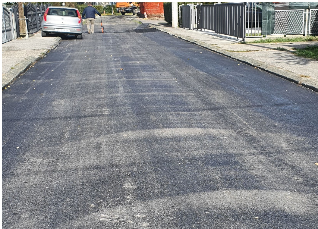
Slika 4.5 Kolnik pošprican bitumenskom emulzijom (vlastiti izvor)
