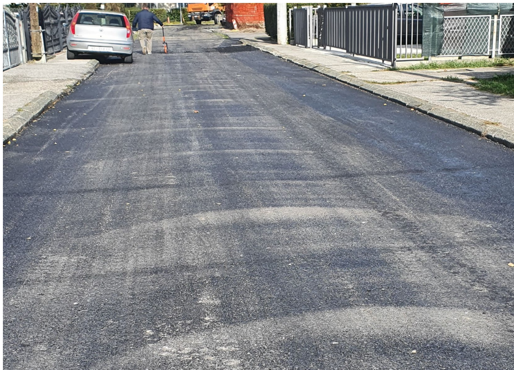
Slika 4.5 Kolnik pošprican bitumenskom emulzijom (vlastiti izvor)
