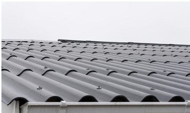
Slika 5.7 Valovita vlknasto-cementna ploča
