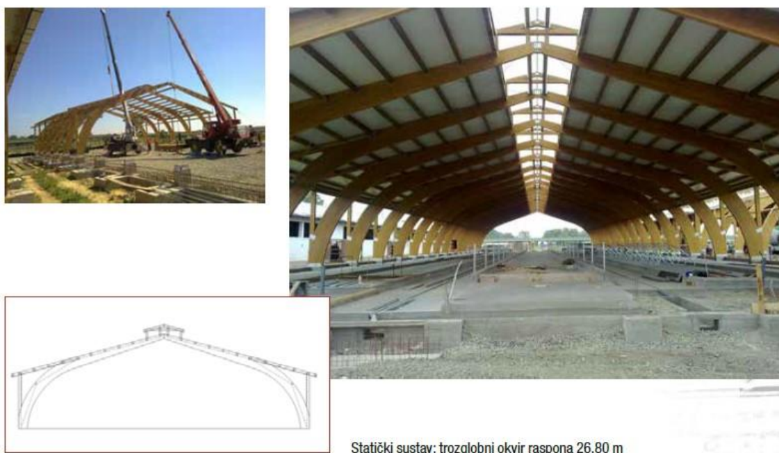
Statički sustav: troglobni okvir raspona 26,80 m
