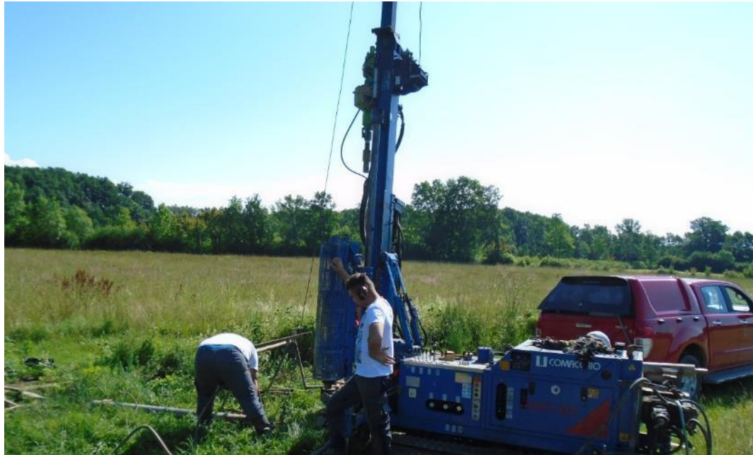
Slika 2.1. Geotehnički istražni radovi na nalazištu
