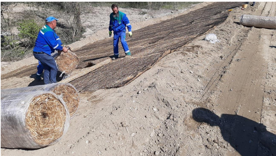
Slika 4.4. Ugradnja geokompozita – VMax SC250 - ojačanje pokosa nasipa
