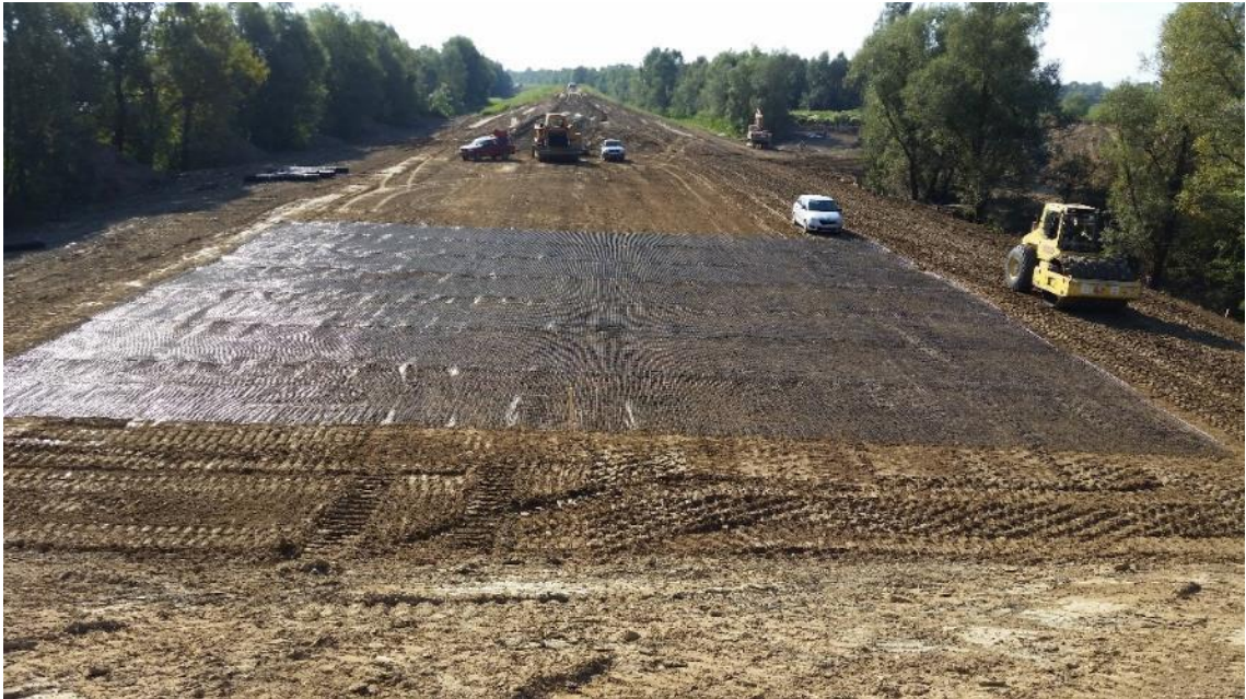
Slika 4.1. Ugradnja geosintetika - troosna geomreža tip Tensar – TriAx TX 190L – armiranje tla
