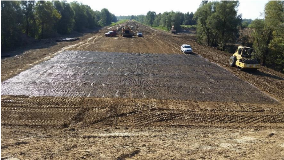
Slika 4.1. Ugradnja geosintetika - troosna geomreža tip Tensar – TriAx TX 190L – armiranje tla
