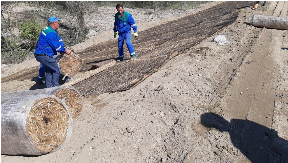
Slika 4.4. Ugradnja geokompozita – VMax SC250 - ojačanje pokosa nasipa
