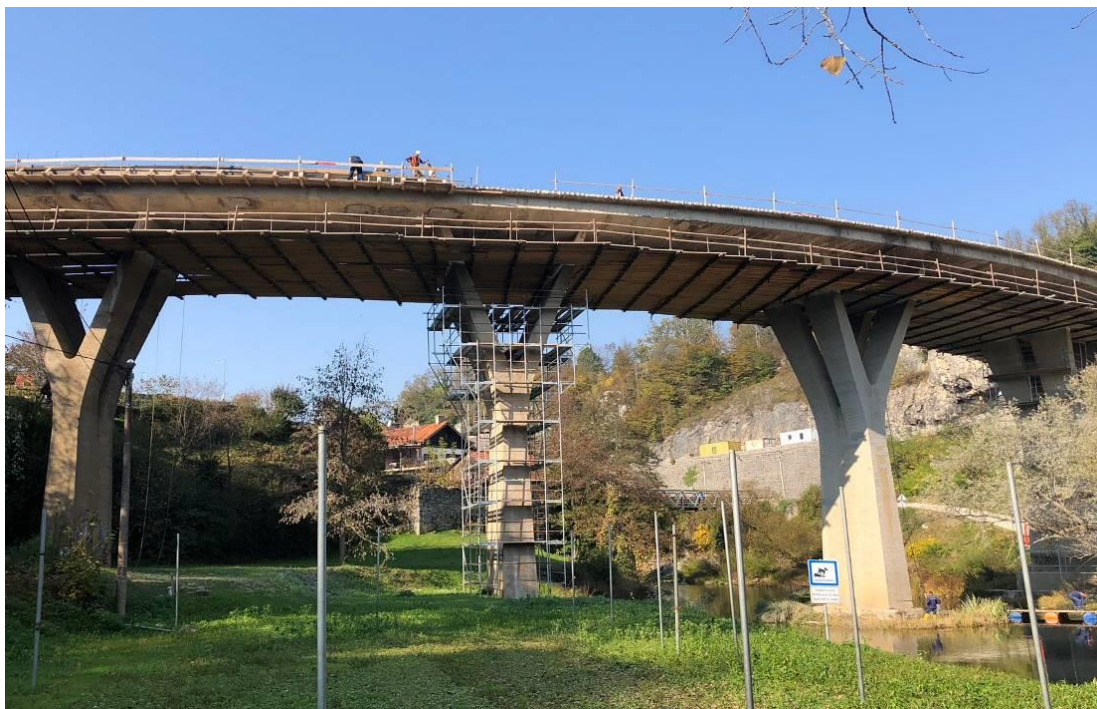
Slika 49. Montaža viseće skele, skele stupova i oplate konzole mosta
