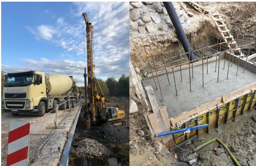
Slika 41. Izrada bušenih pilota i betoniranje naglavne grede pilota
