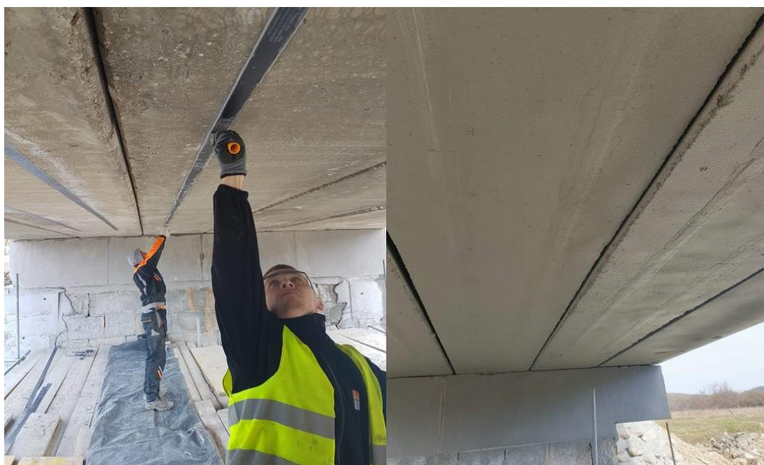
Slika 44. Ojačanje nosača ugradnjom karbonskih lamela te zaštitni sustav podgleda mosta
