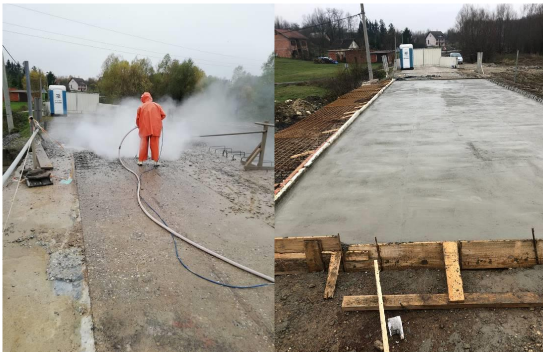
Slika 43. Hidrodinamičko uklanjanje oštećenog betona, armature i betoniranje nove kolničke ploče
