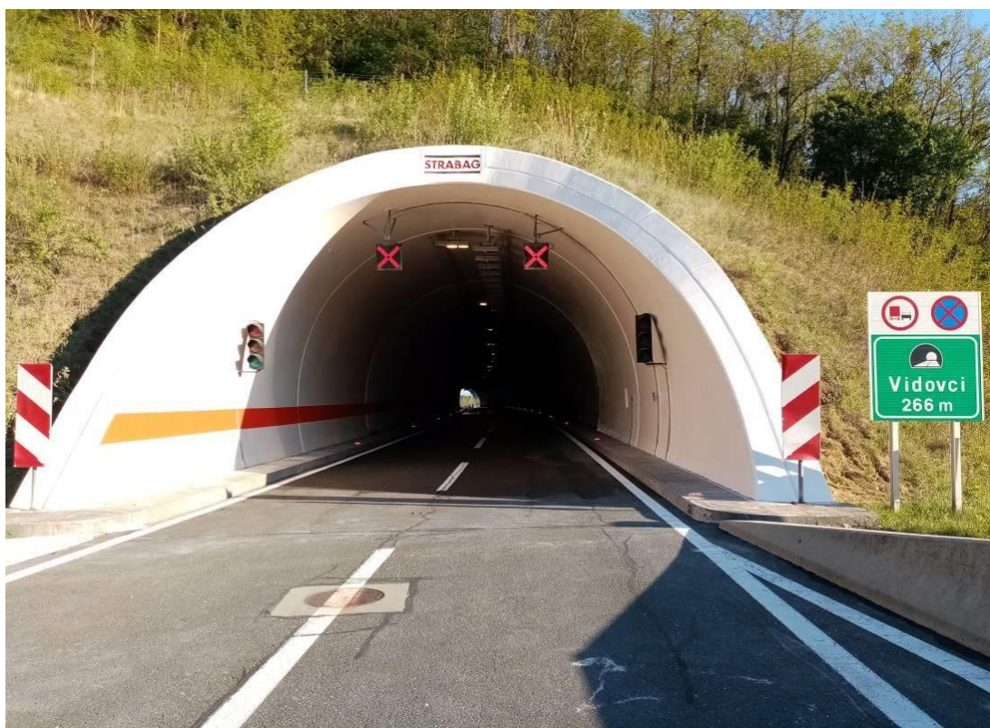
Slika 61. Izgled obloge nakon završenih sanacijskih radova
