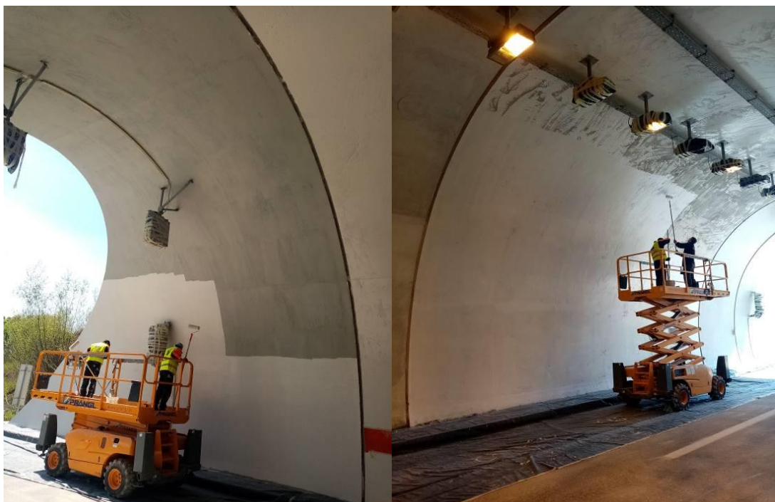
Slika 60. Nanošenje završnog zaštitnog sustava
