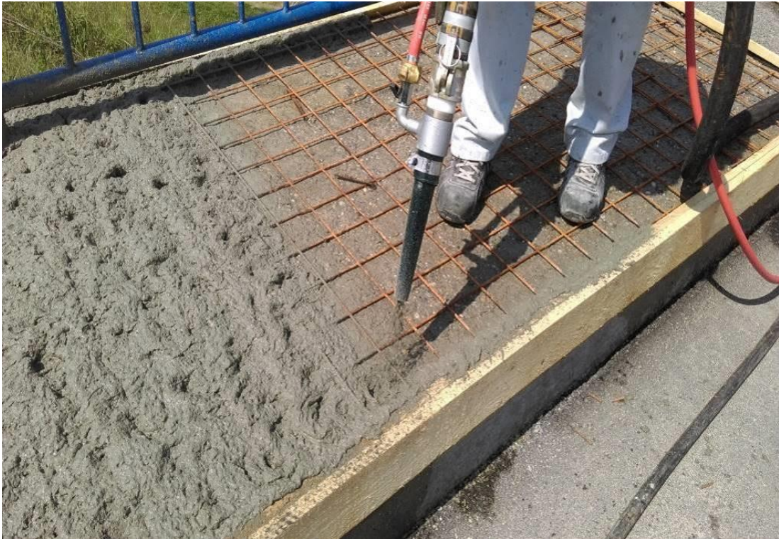
Slika 26. Reprofilacija hodnika mosta Siščani reparaturnim mortom
