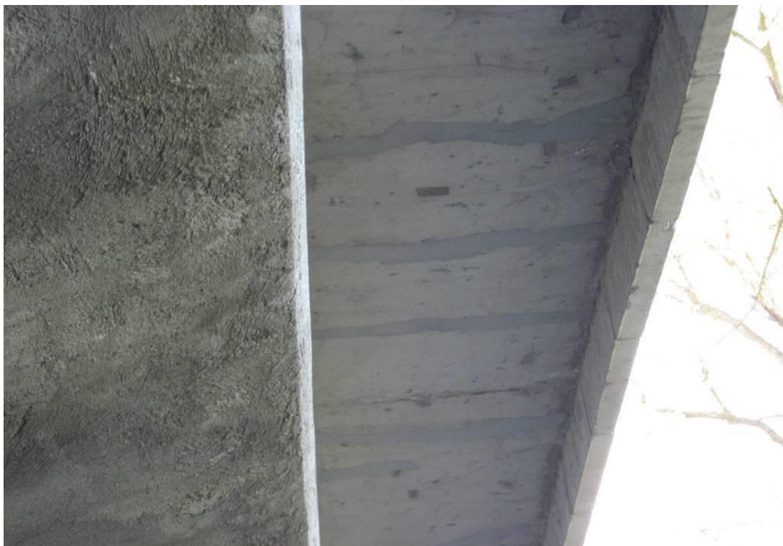
Slika 34. Brtvljenje traga pukotine
