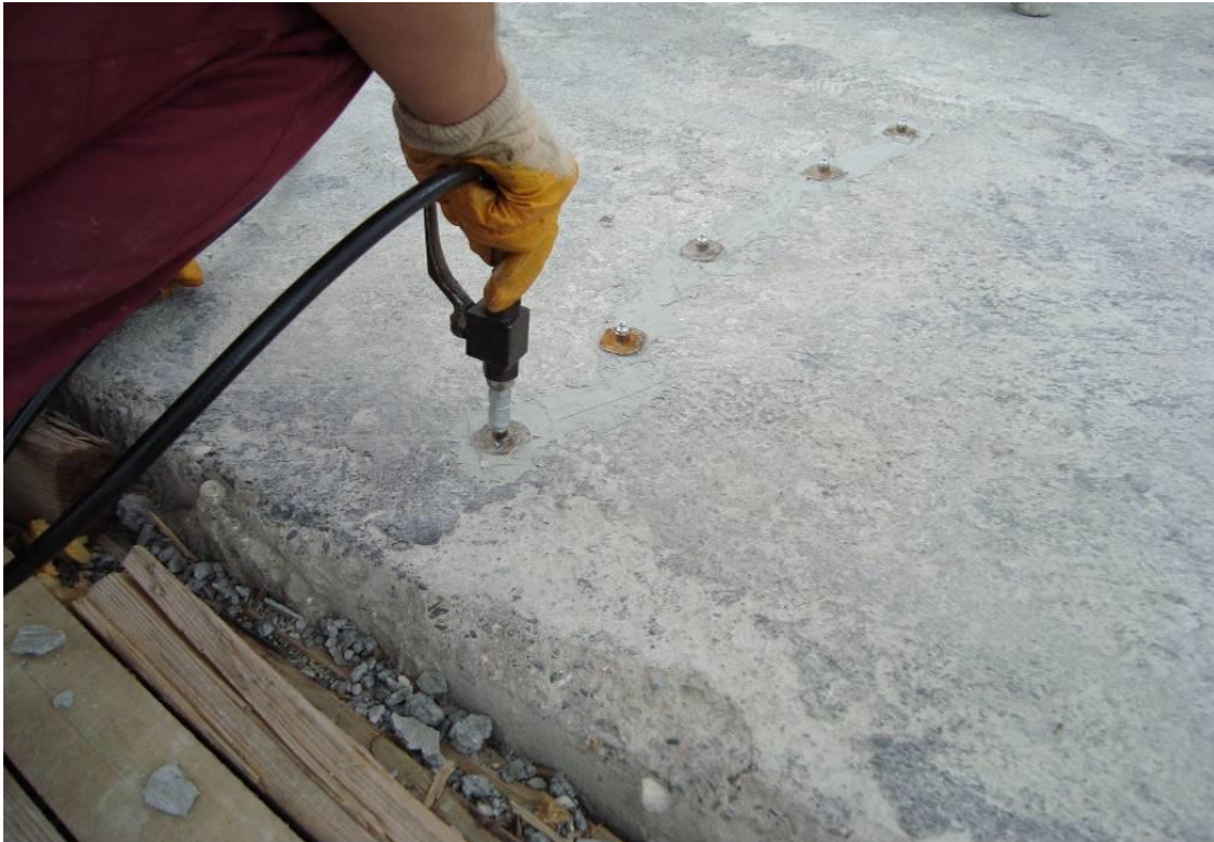
Slika 32. Injektiranje kolničke ploče mosta lijepljenim pakerima
