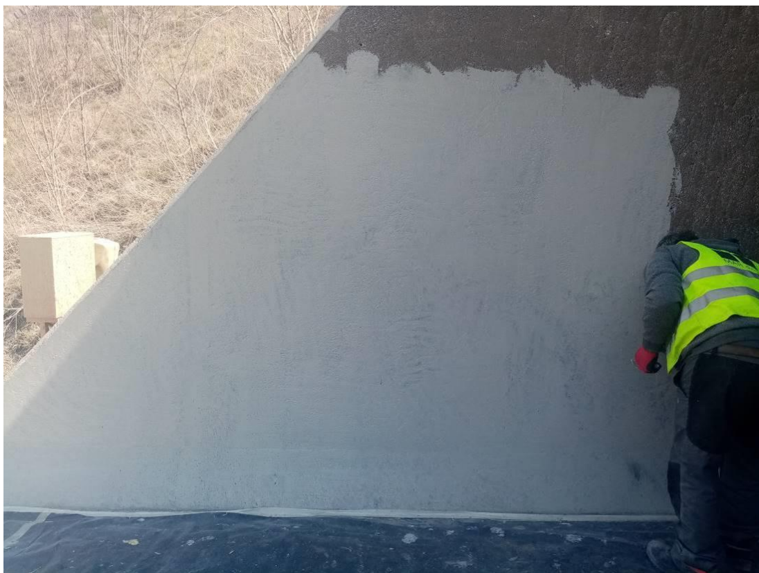
Slika 58. Sanacija lokalnih oštećenja i nanošenje primera
