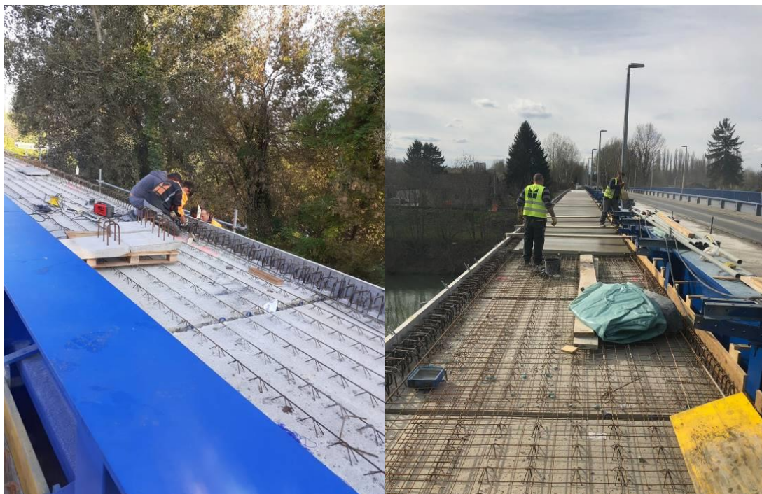
Slika 68. Montaža vijenaca, armature, i ugradnja betona novih pješačkih hodnika
