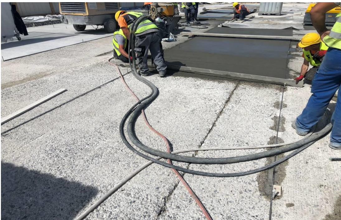
Slika 76. Reprofilacija kolničke ploče nakon uklanjanja oštećenog betona
