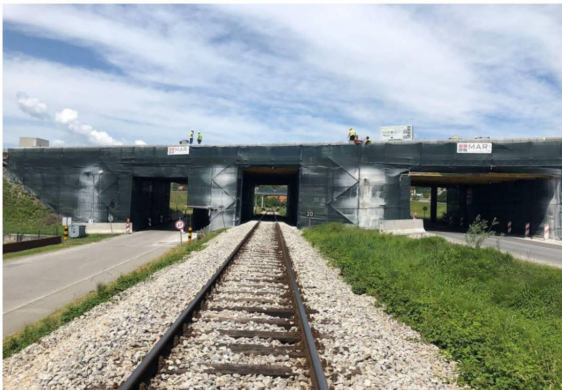
Slika 21. Ispravno postavljena skela sa zaštitnim tunnelima i mrežama na nadvožnjaku Zabok
