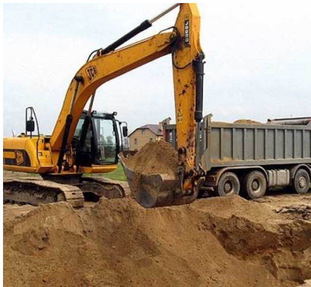
Slika 3.1.1. Strojni iskop zemljanog materijala
