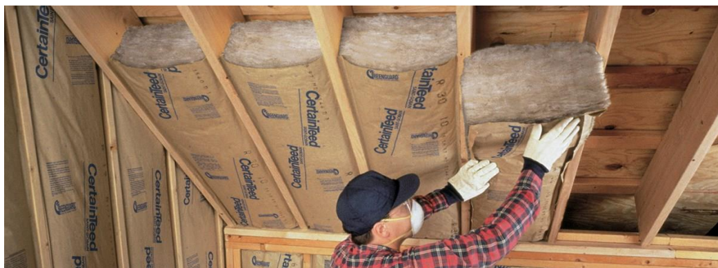
Slika 4.1.3. Oblaganje krovišta staklenom vunom
