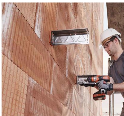
Slika 6.2.2. Postavljanje nosača
