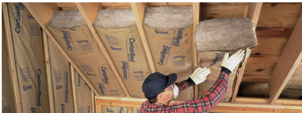
Slika 4.1.3. Oblaganje krovišta staklenom vunom
