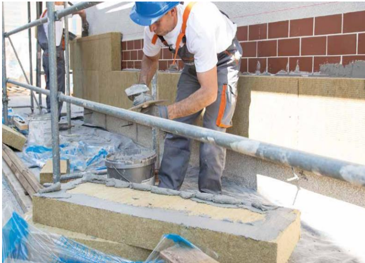
Slika 4.1.1. Izoliranje zida kamenom vunom
