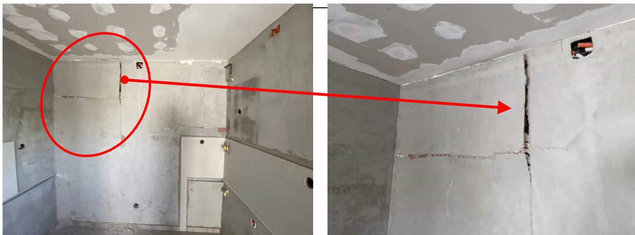
Slika 4.12. Pregradni zidovi etaže 2 (krajnja prostorija);
