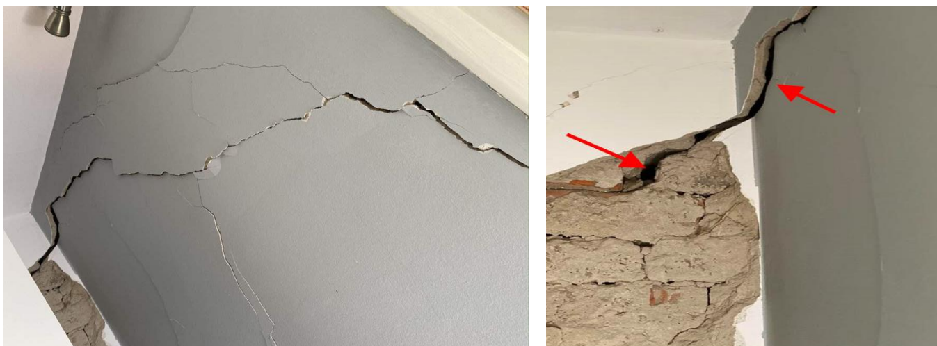
Slika 4.3. Jugoistočni kut zgrade; unutrašnjost;
