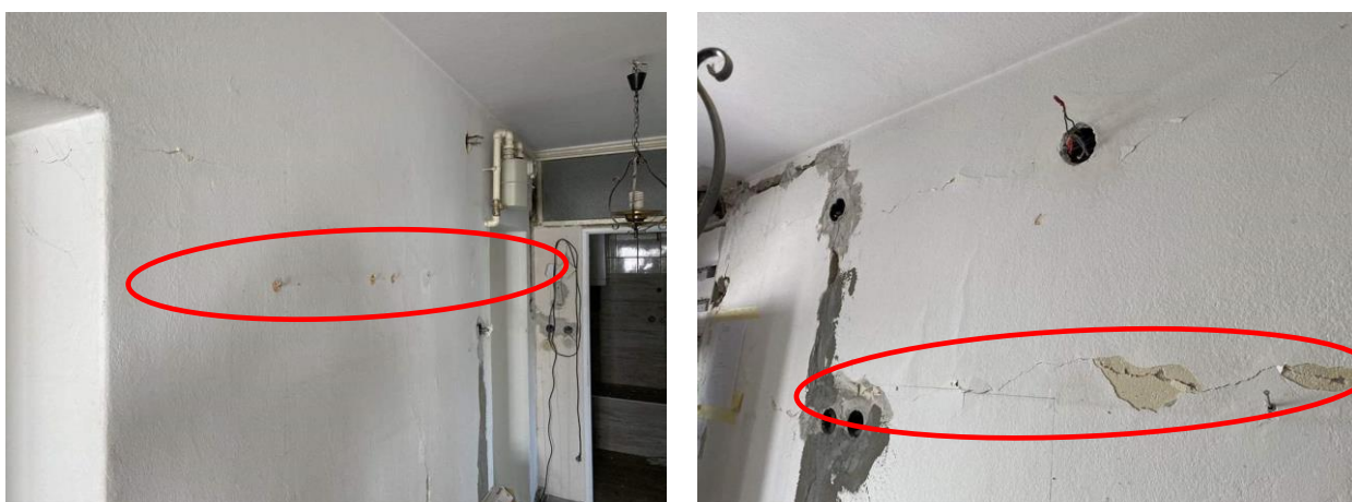
Slika 4.13. Unutrašnji zidovi prizemlja etaže 2;
