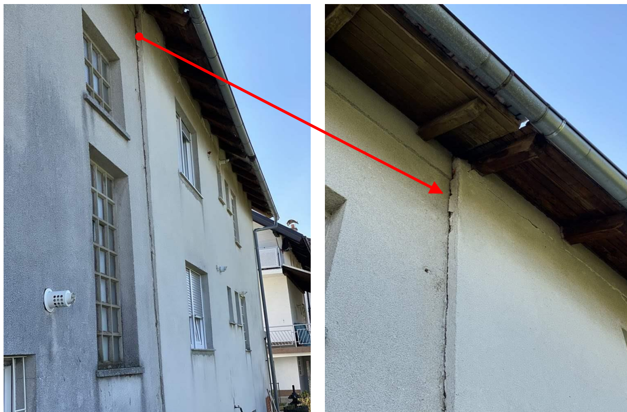
Slika 4.22. Sjeverno pročelje, pogled na dilataciju sa zapadnom građevinom;
