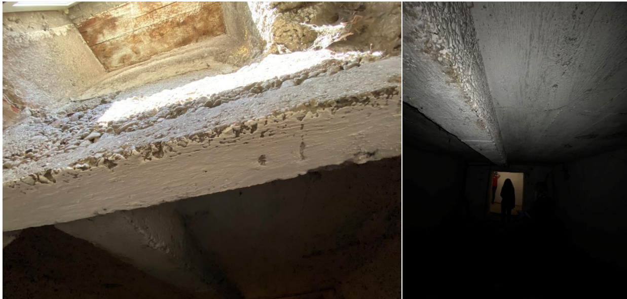
Slika 4.43. Nosivi sustav ploče prizemlja
