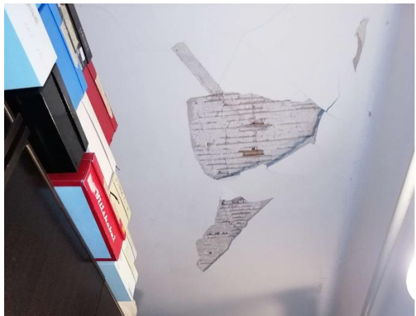
Slika 4.18. Teška strukturalna oštećenja te opadanja velikih količina žbuke sa stropova
