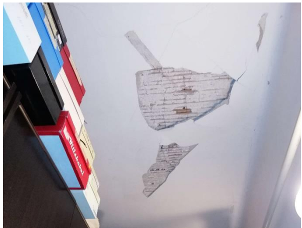
Slika 4.18. Teška strukturalna oštećenja te opadanja velikih količina žbuke sa stropova
