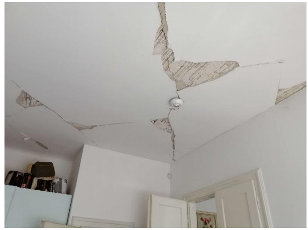
Slika 4.16. Spavaća soba također ispunjena stropnim unakrsnim pukotinama
