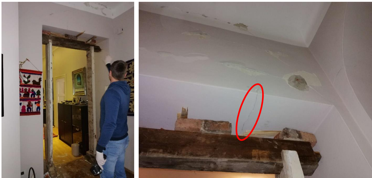
Slika 4.3. Oštećenje nadvoja
