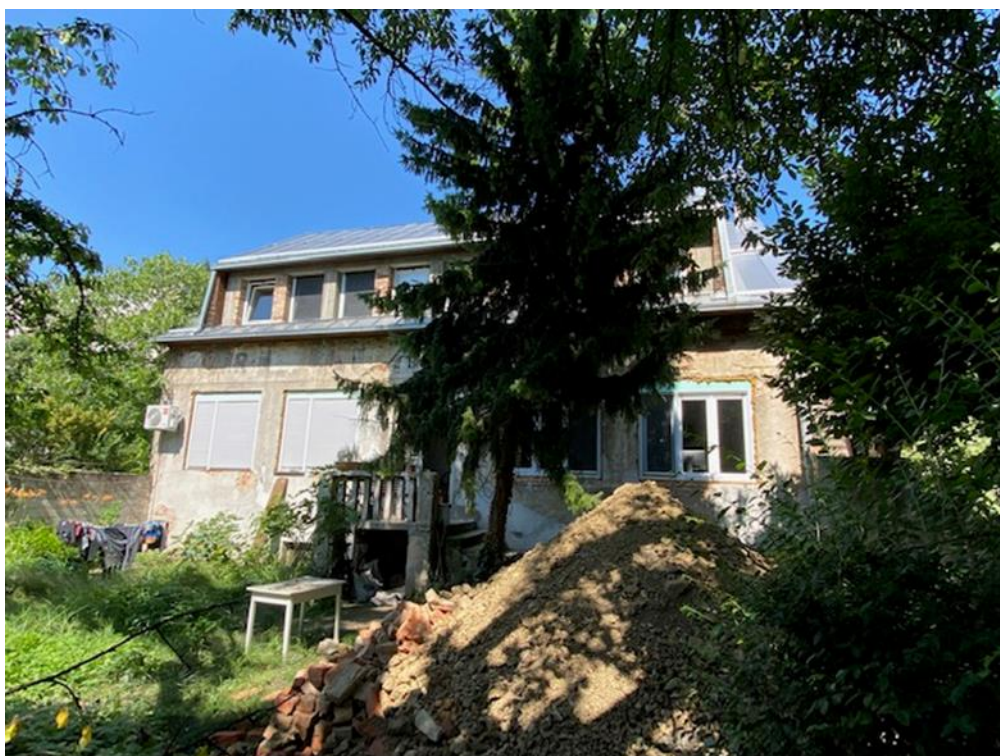
Slika 3.11. Pogled na zapadno pročelje predmetne zgrade
