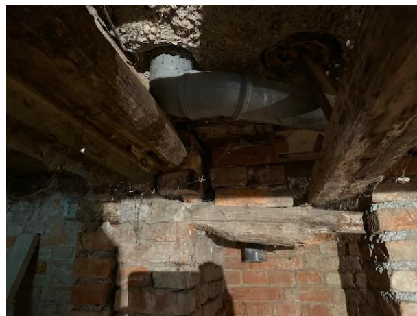
Slika 3.12. Prikaz stropne konstrukcije u podrumu
