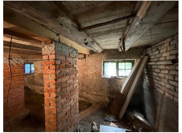
Slika 3.15. Prikaz stropne konstrukcije u podrumu
