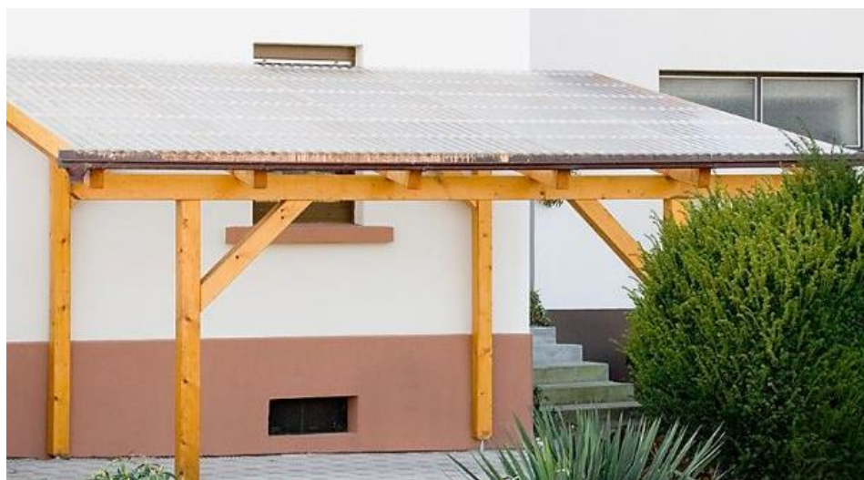
Slika 3.33 Pokrov od polikarbonatnih ploča
