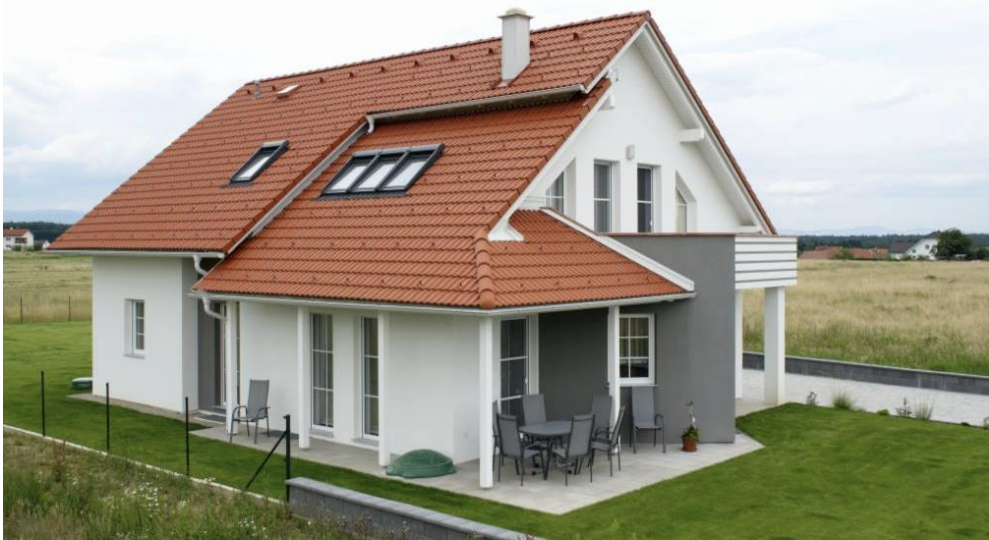
Slika 3.16 Pokrov od betonskog utorenog crijepa
