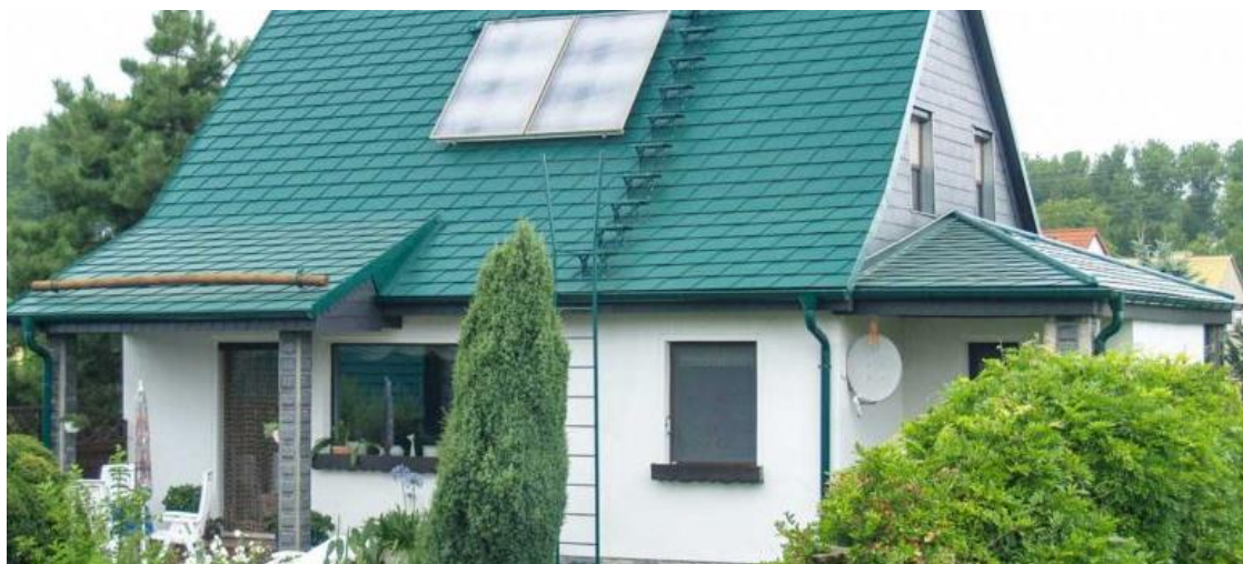
Slika 3.31 Pokrov od metalne šindre
