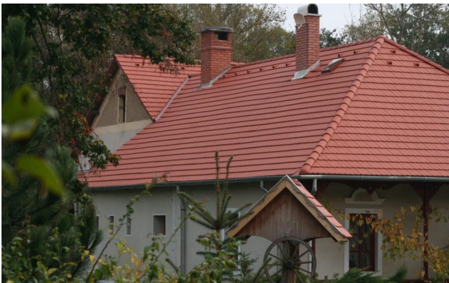
Slika 3.15 Pokrov od betonskog biber crijepa
