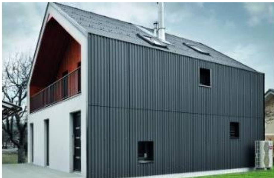
Slika 3.18 Pokrov od velikoformatnih vlakno-cementnih ploča
