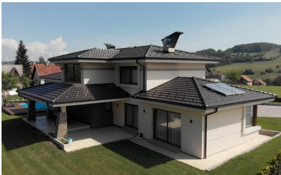
Slika 3.14 Pokrov od glinenog utorenog crijepa
