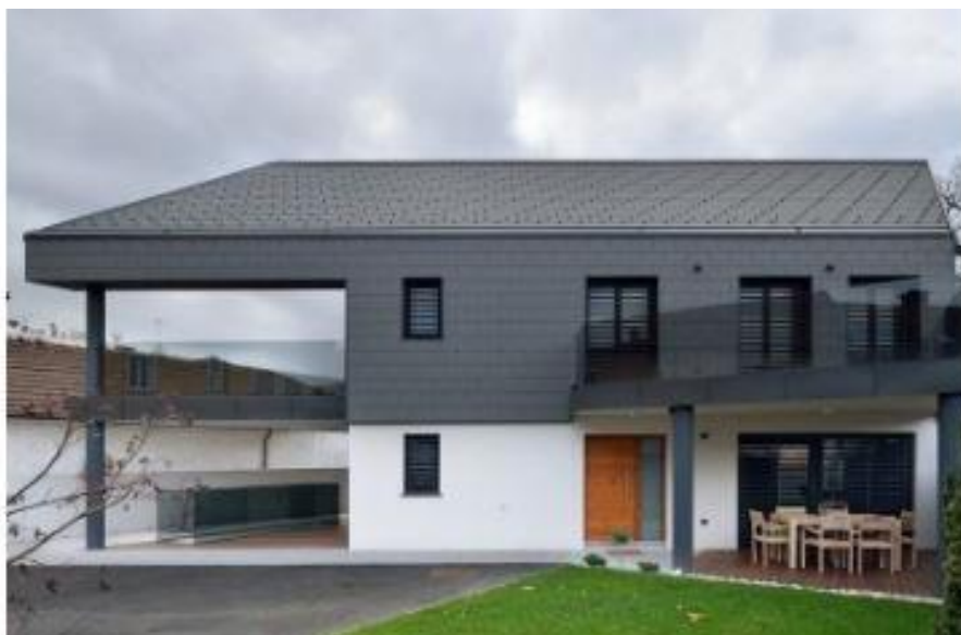
Slika 3.20 Pokrov od maloformatnih vlakno-cementnih ploča
