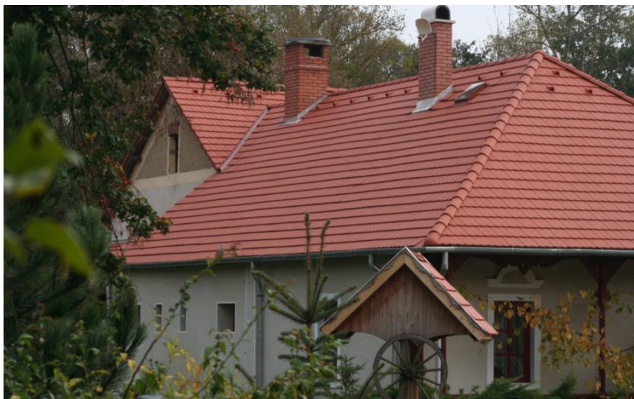
Slika 3.15 Pokrov od betonskog biber crijepa
