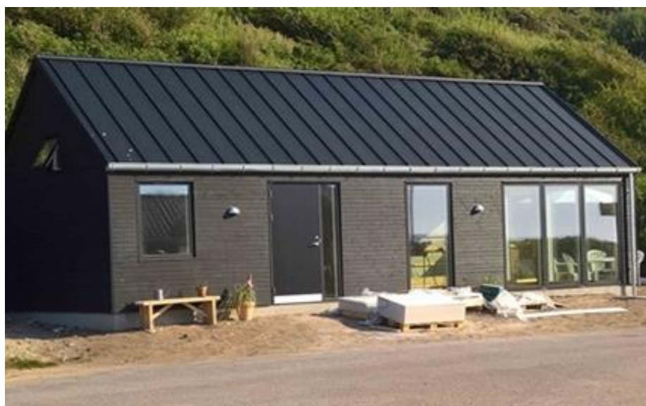
Slika 3.25 Pokrov od ravnih metalnih ploča
