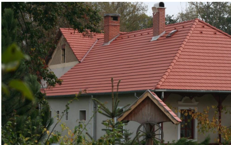
Slika 3.15 Pokrov od betonskog biber crijepa
