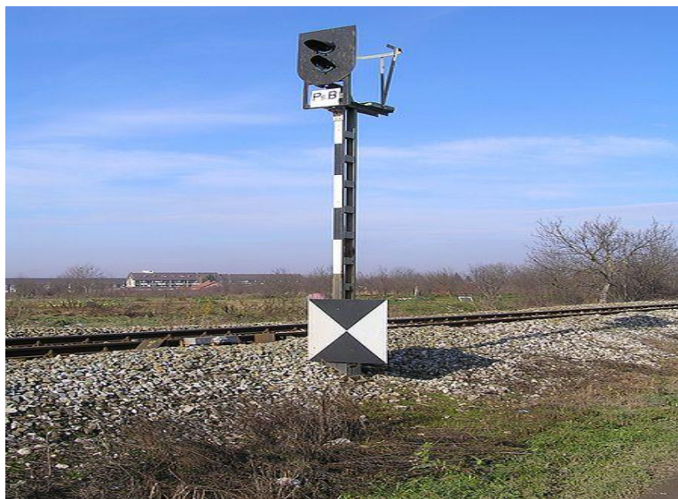
Slika 44. Željeznički predsignal glavnom signalu
