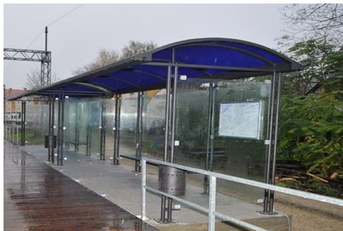
Slika 40. Nadstrešnica putnika u željezničkim stajalištima/kolodvorima
