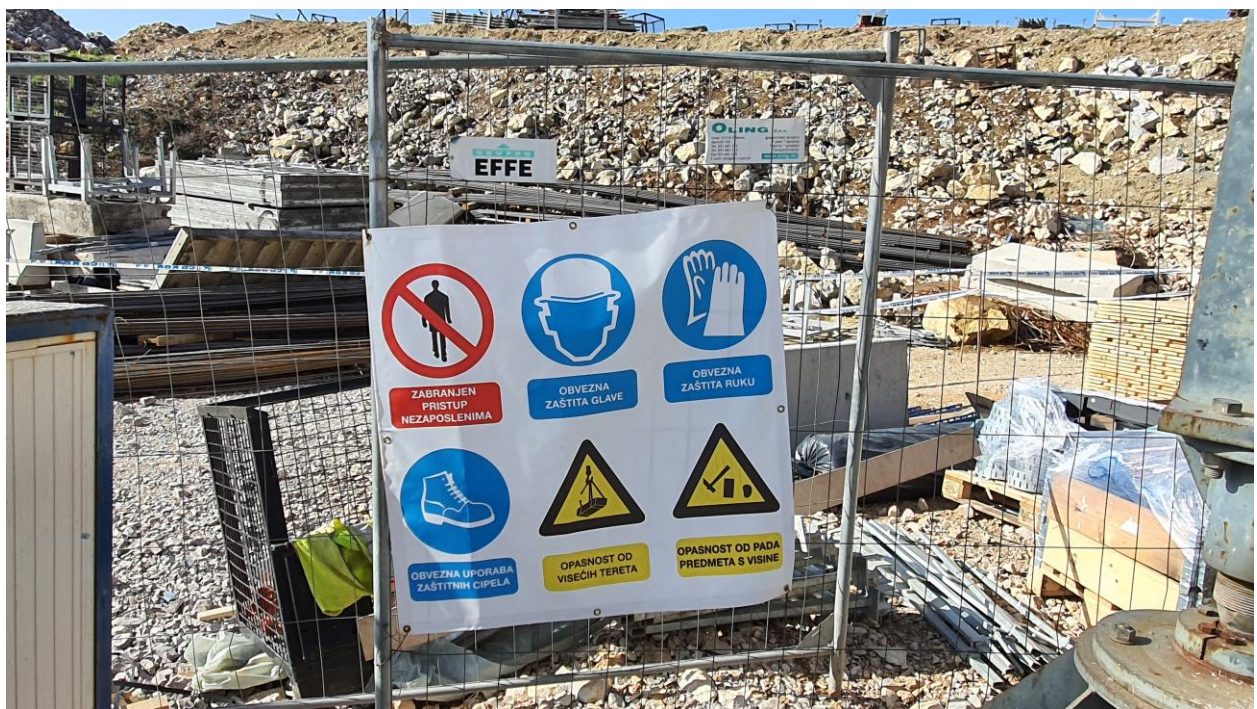
Slika 4.1.10-2 Tabla ulaz na gradilište
