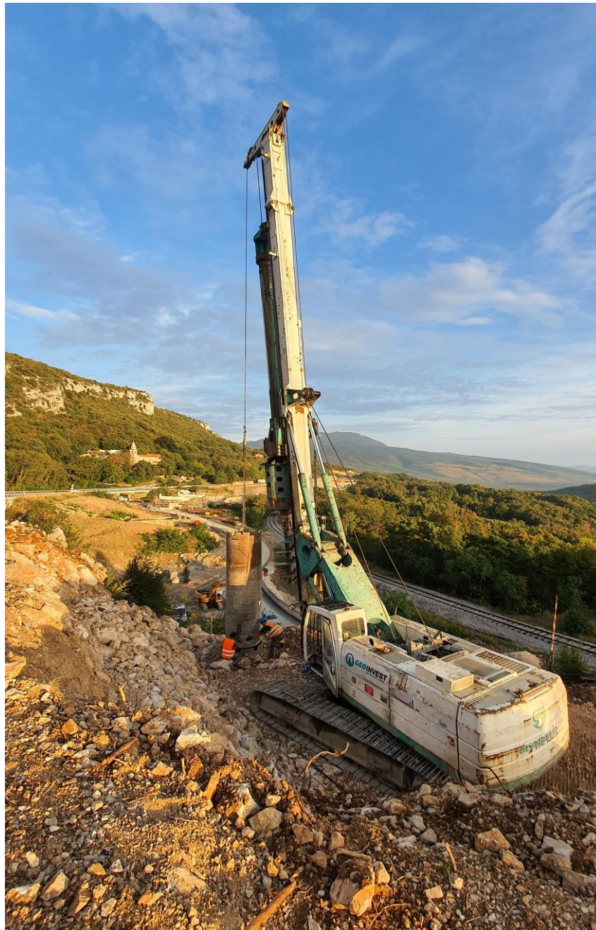
Slika 4.1.1-1 Bušaći stroj Casagrande B180
