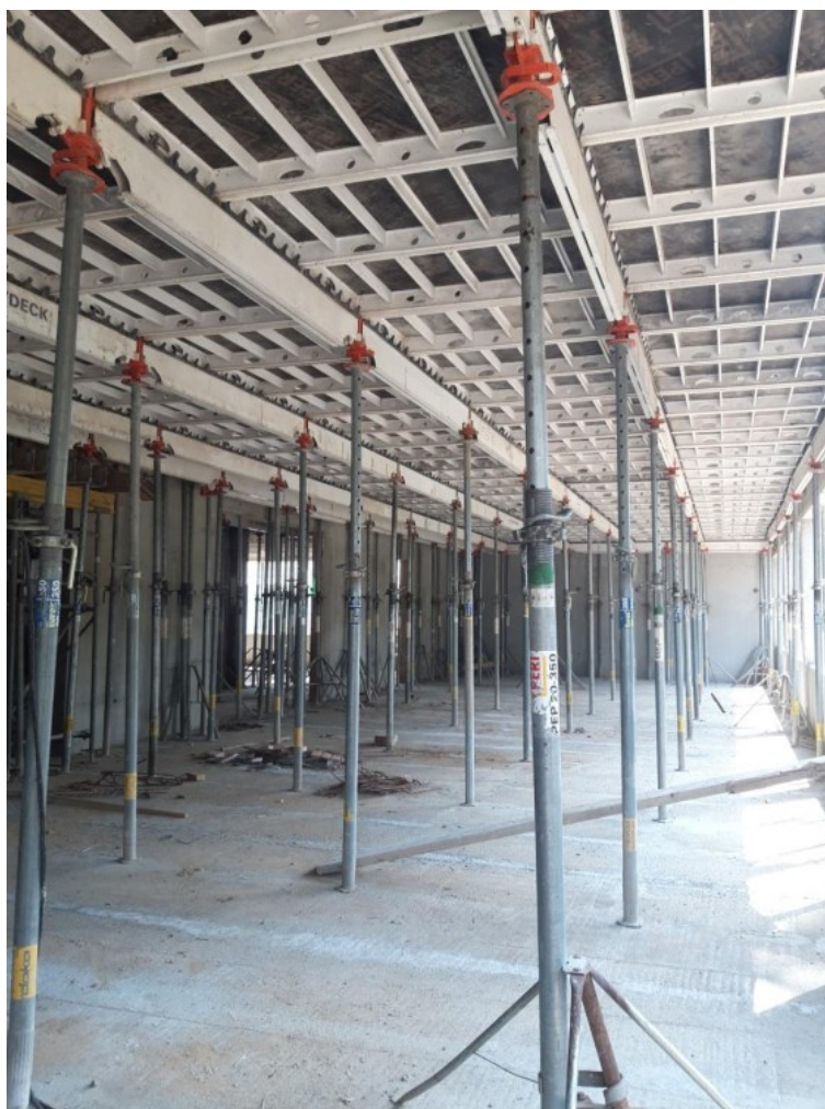
Slika 8: Prikaz postavljene oplata i podupirača
