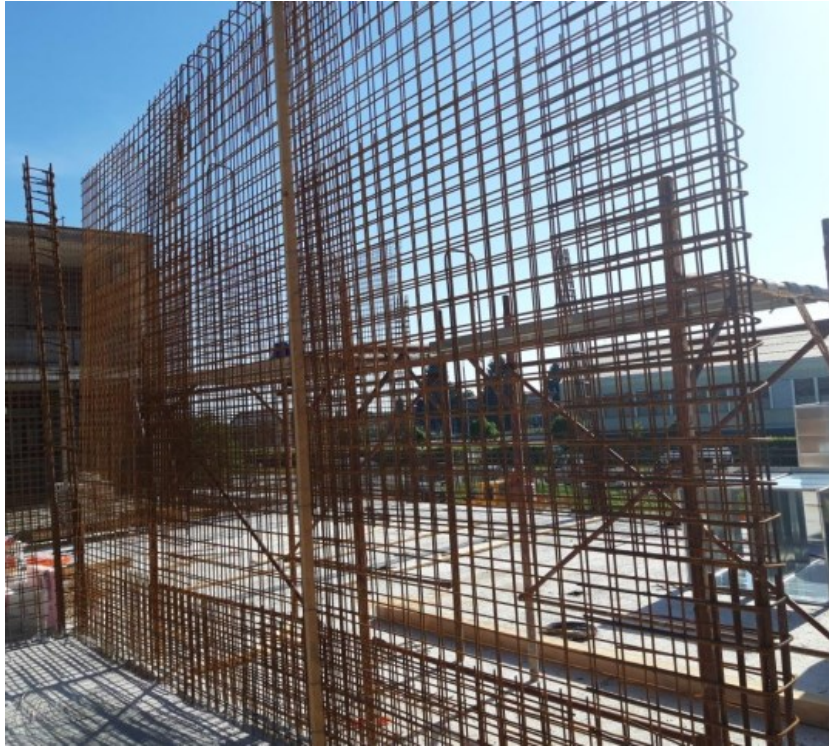
Slika 6 : Armiranje zida
