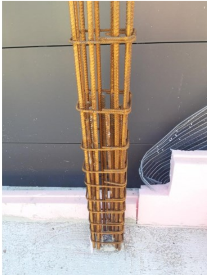
Slika 5: Armiranje stupa
