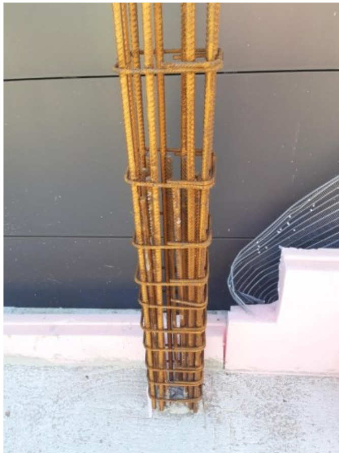
Slika 5: Armiranje stupa
