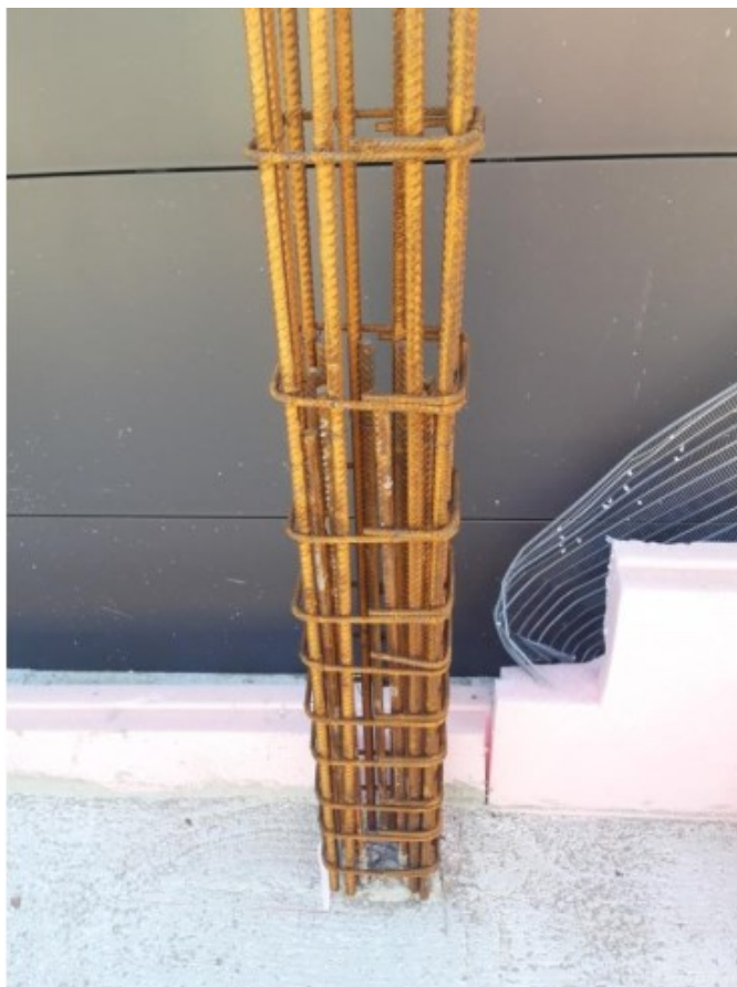
Slika 5: Armiranje stupa
