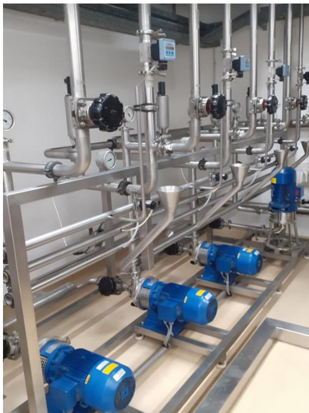
Slika 3.19. Distribucijske pumpe i distribucijske petlje (vlastiti izvor)
