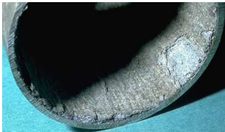
Slika 4 - Primjer selektivne korozije
