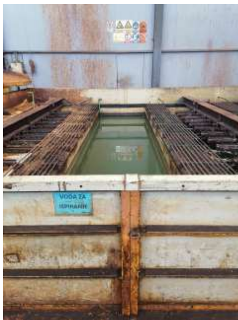
Slika 15 - Voda za ispiranje
