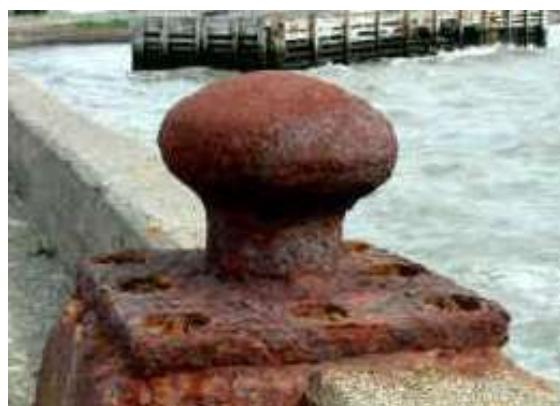
*Slika 1 - Primjer opće korozije na metalnom predmetu zbog djelovanja morske vode*
