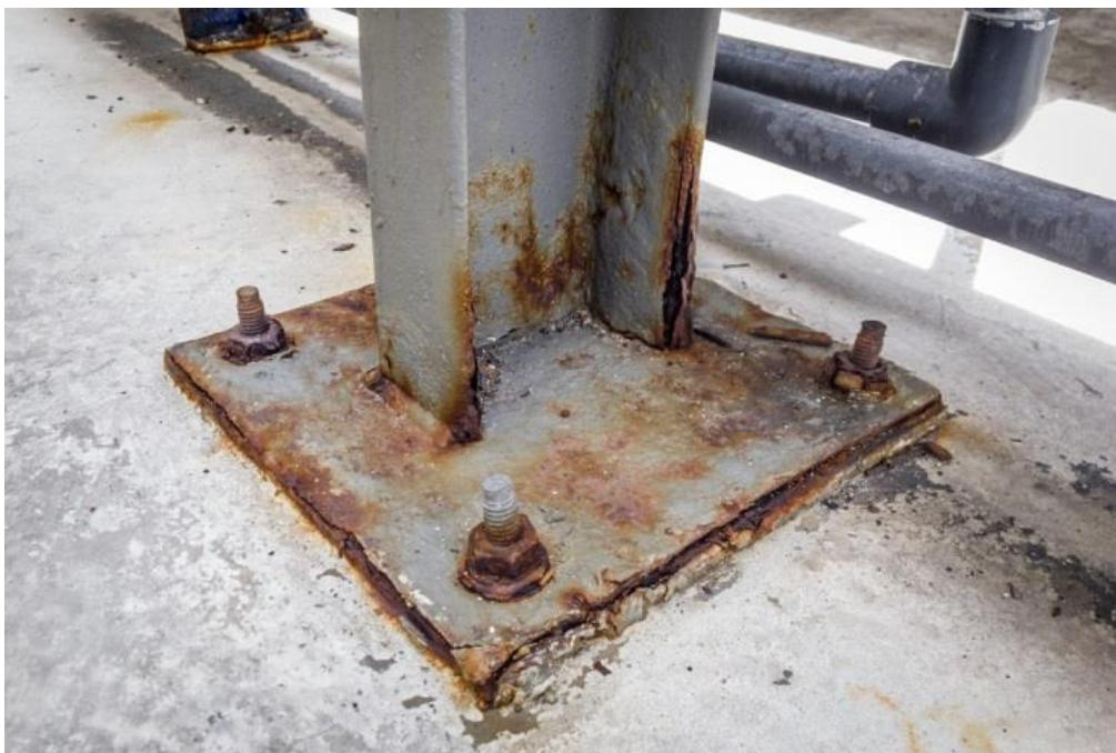
*Slika 4: Korozija u procijepu na loše izvedenim zavarima stupu i temeljne ploče [9]*
