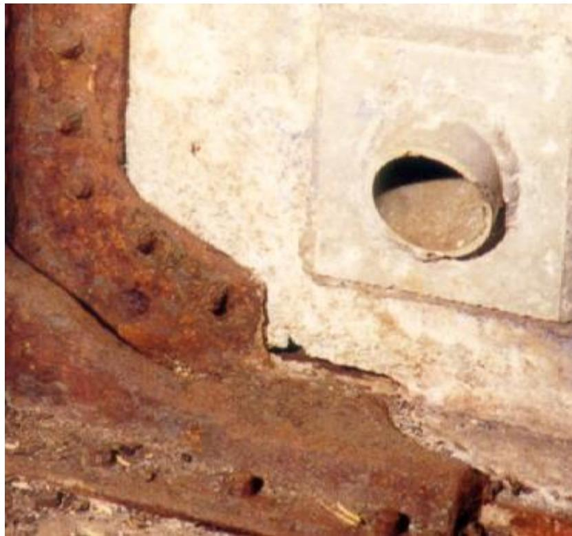
*Slika 3: Galvanska korozija između aluminijskog i čeličnog elementa u dodiru [8]*
