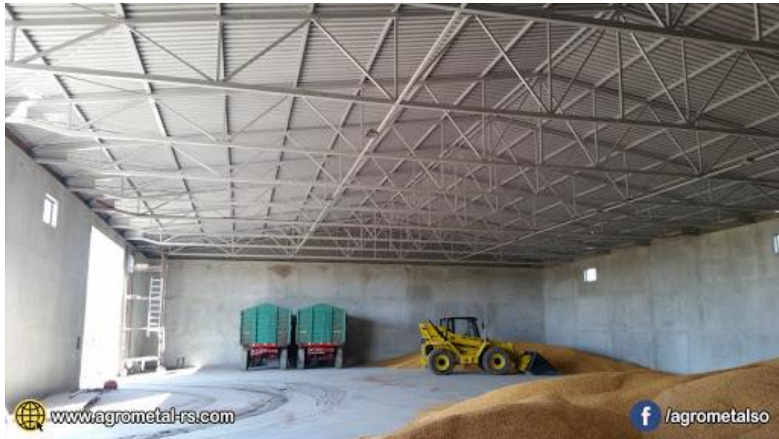
Slika 1. Podno skladište za rasute terete
