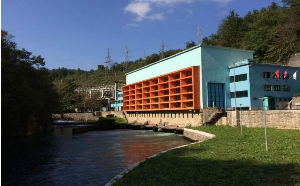
Slika 3.2.4. Izlaz vode iz strojarnice ispod upravne zgrade HE Gojak
