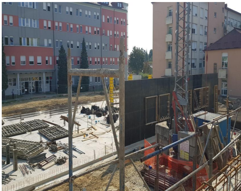
Slika 4.9. Prikaz početka oplata zidova Jednodnevne kirurgije i OHBP- osobna arhiva 2020 godine
