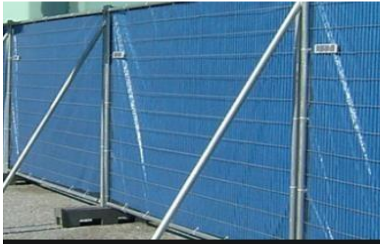
Slika 3.11. Gradilišna ograda
