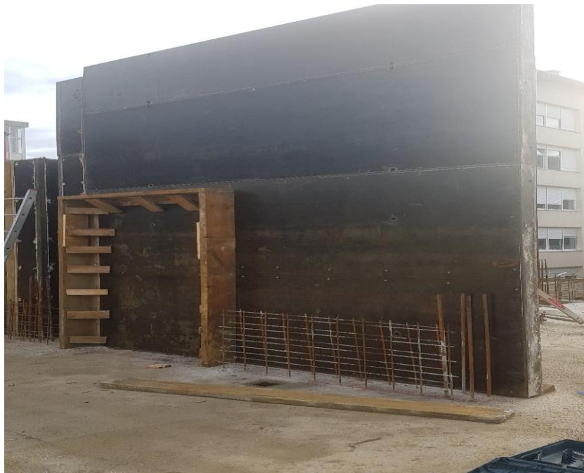
Slika 4.8. Okvirni sustav Doka Framax-osobna arhiva 2020 godine
