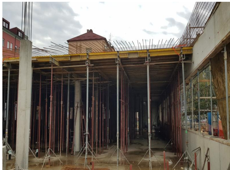
Slika 4.14. Okvirni sustav Doka Dekaflex-izvor sa gradilišta
