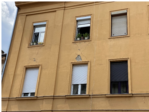
Slika 11. Istočno pročelje zgrade s detektiranim „X“ pukotinama nadvoja
