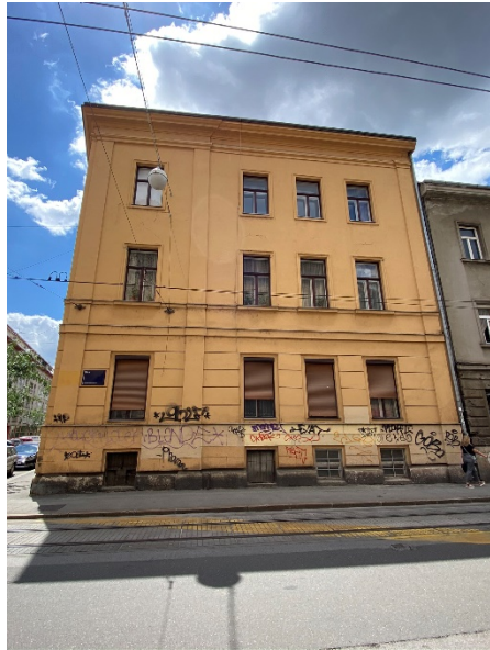
Slika 14. Sjeverno pročelje zgrade koje gleda na Ilicu
