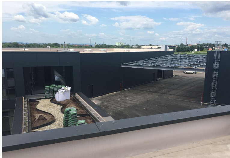
Slika 5.16 Nadstrešnica između dilatacije A i D
