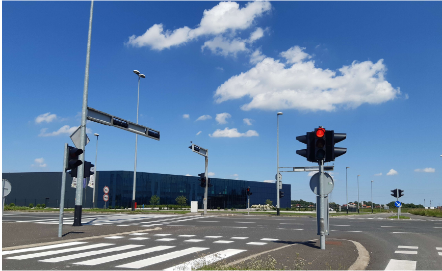
Slika 5.24 Prikaz pristupa parceli nakon izgradnje
