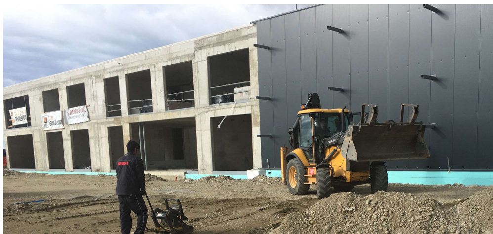
Slika 5.7 Vanjski zidovi dilatacije B
