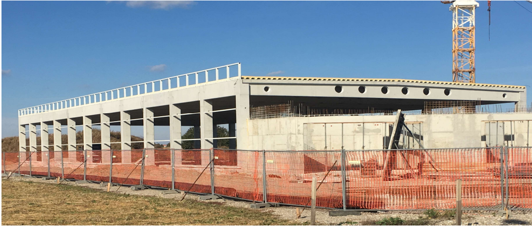
Slika 5.14 Ograda oko gradilišta
