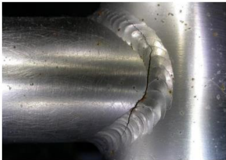
Slika 14. Pukotina otkrivena pomoću VT
