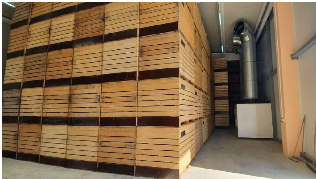
Slika 22. Puna rashladna komora
