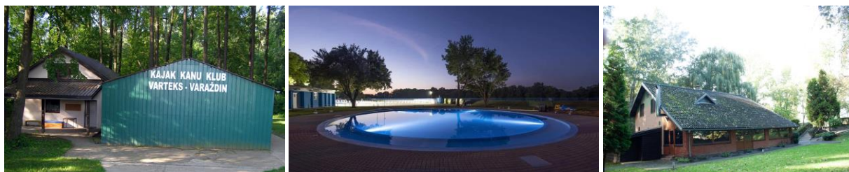
Slika 3.4 Objekt i skladište, „Kajak kanu klub Varteks - Varaždin“. Izvor: http://www.kkkvarteks.hr/kkkv/ona/ Dostupno 07.07.2021.
