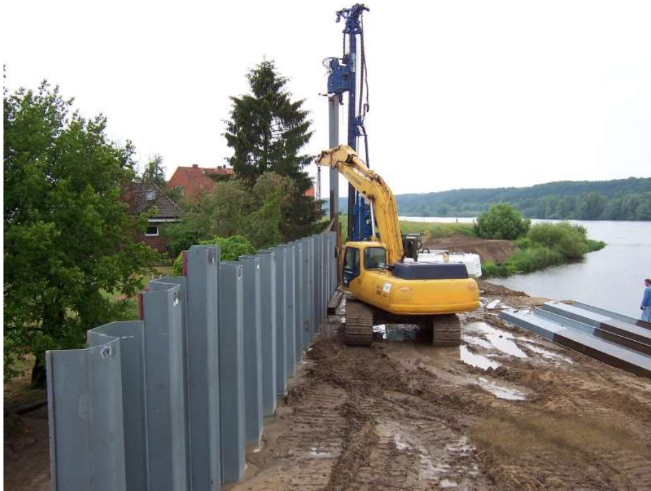
Slika 21 : Postavljanje metalnog žmurja
