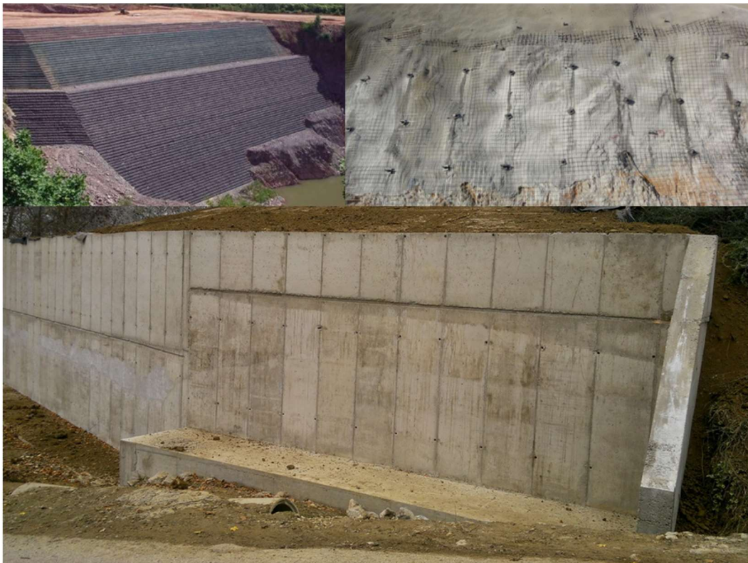
Slika 1 : Potporne građevine: ojačano tlo(gore lijevo), geotehničko sidro (gore desno), potporni zid (dolje)
