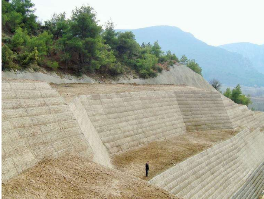
Slika 18 : Primjer ojačanog tla iz Rusije
