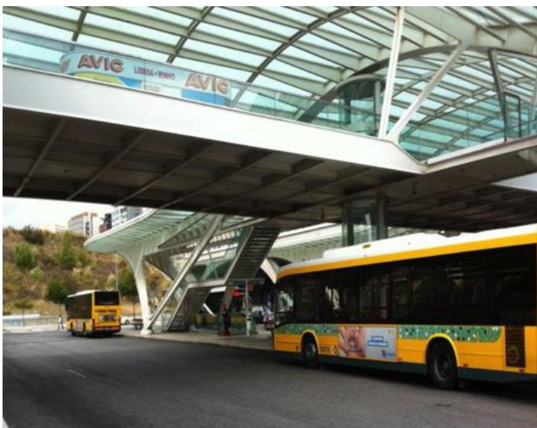
Slika 14. Transportni terminal u Lisabonu – spojena točka željezničkog, autobusnog, metroa u taksiji prijevoznog sustava
