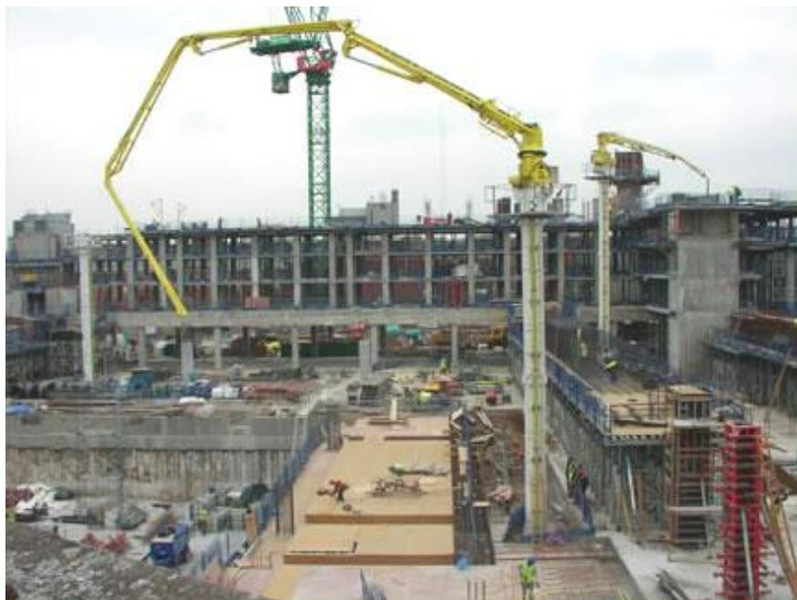
Slika 5.1 Sustav za transport betona [19]
