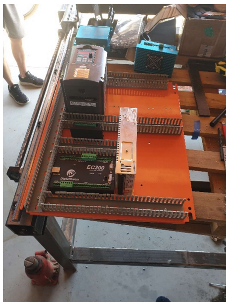
Slika 4.7 Postavljanje prvih komponenti
