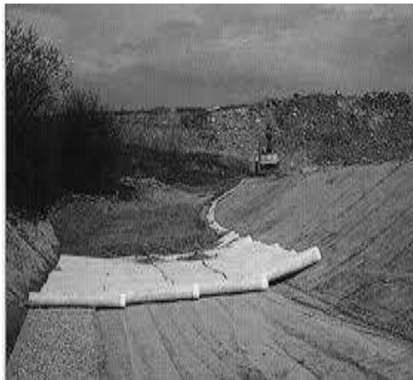
Slika 3.1.3. Primjer polaganja geotekstila u praksi
