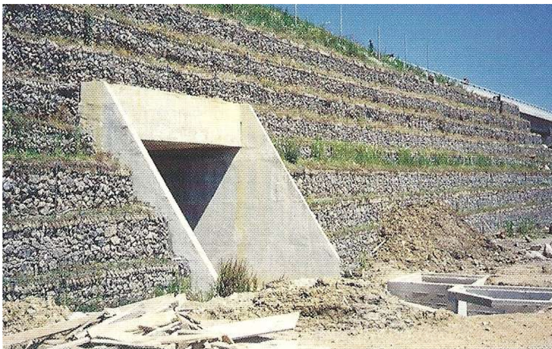
Slika 4.2.4 Izljevna glava propusta u praksi
