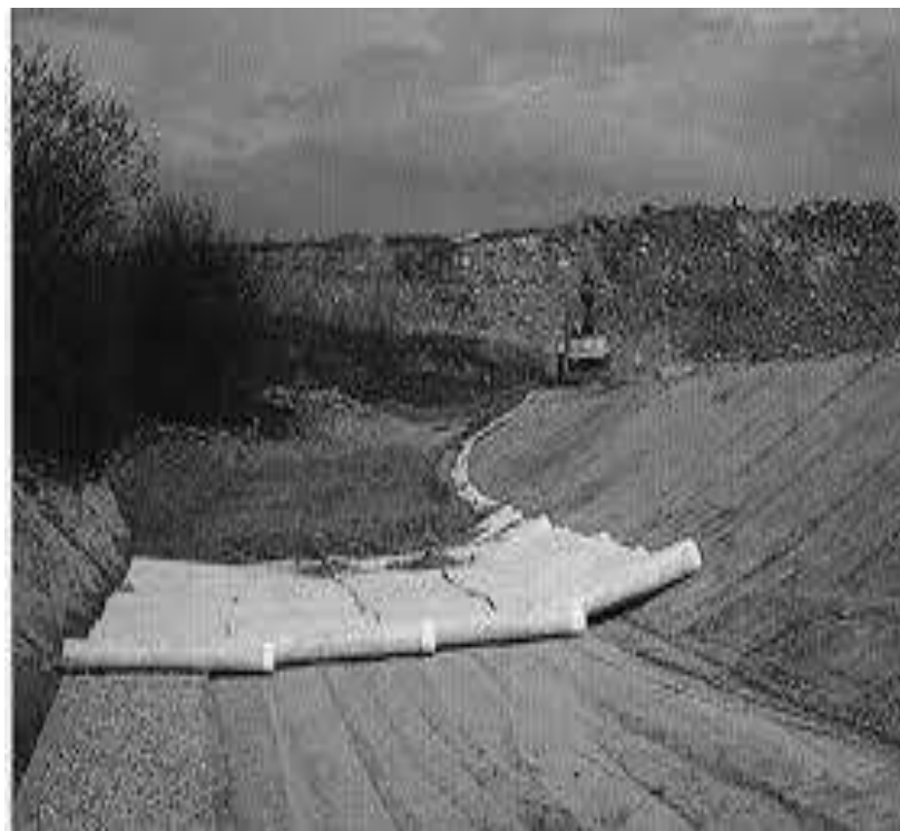
Slika 3.1.3. Primjer polaganja geotekstila u praksi
