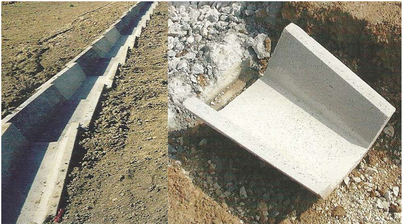
Slika 2.3.8. Detalj predgotovljenog otvorenog kanala
