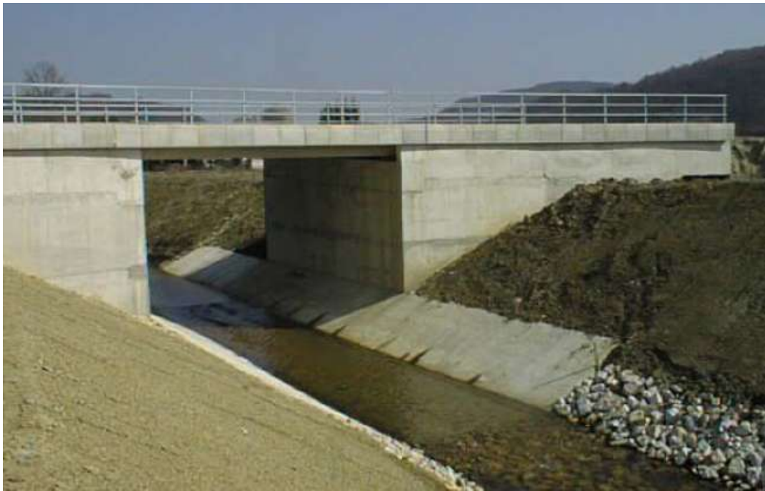
Slika 4.1.3.3. Gotovi pločasti propust u praksi
