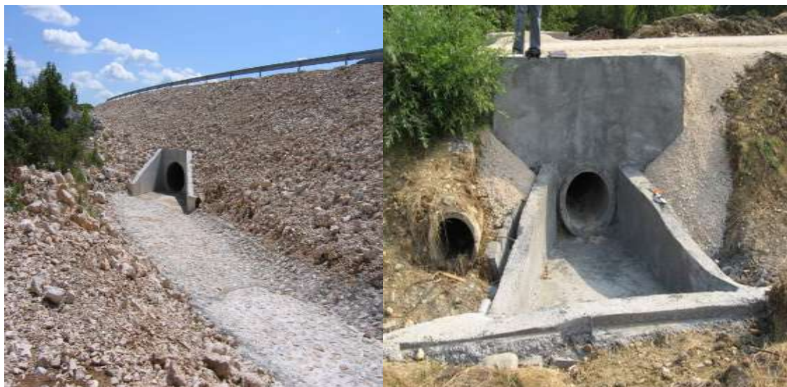
Slika 4.1.1.4 Cijevni propusti u praksi
