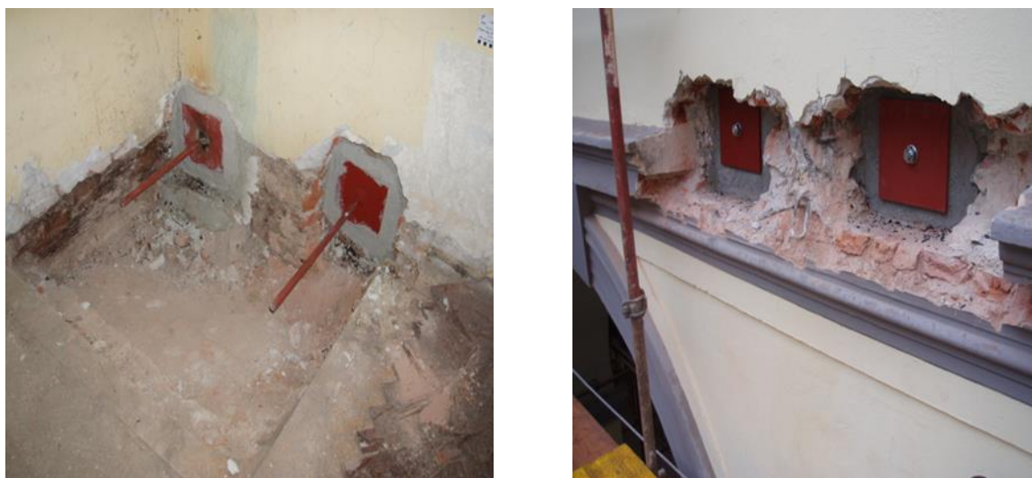
Slika 5.6 Detalj spoja zatege i zida
