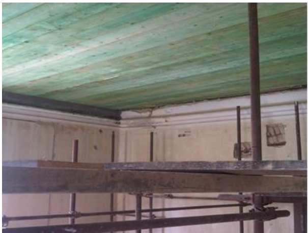
Slika 5.18 Fotodokumentacija rekonstruirane drvene međukatne konstrukcije
