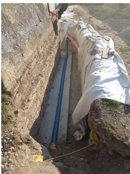
Slika 5.29 Izvođenje drenažnog sustava
