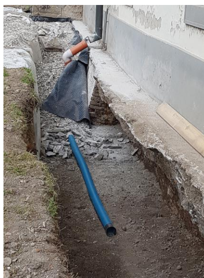
Slika 5.29 Izvođenje drenažnog sustava
