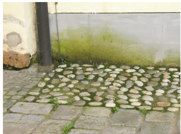
Slika 3.25 Fotodokumentacija oštećenja od vlage
