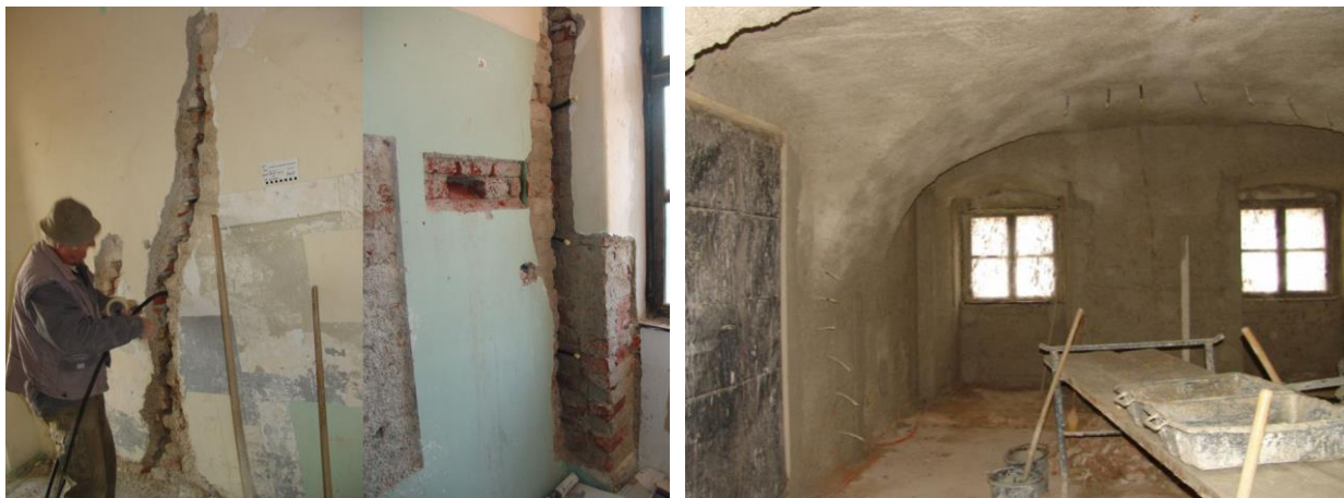
Slika 5.10 Sanacija vanjskih zidova
