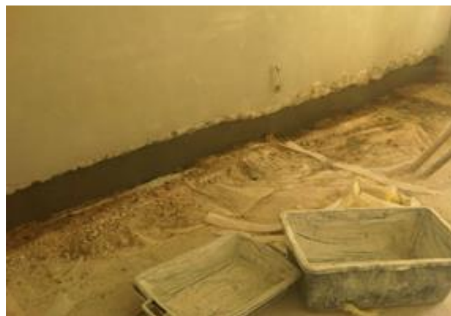
Slika 5.27 Sanacija oštećenja od vlage
