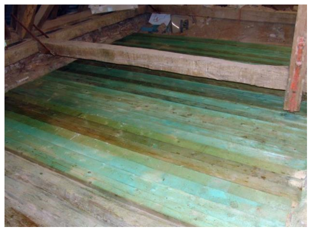
Slika 5.18 Fotodokumentacija rekonstruirane drvene međukatne konstrukcije
