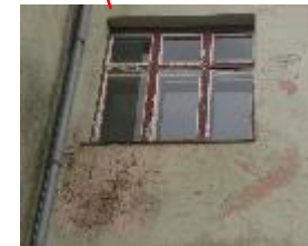
Oštećenje fasade zbog prisutnosti vlage
