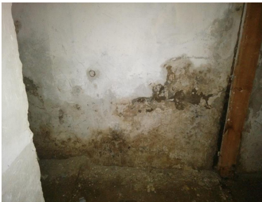
Slika 5.5 Učinci kapilarne vlage u podrumskim zidovima
