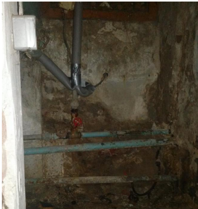
Slika 5.12 Dotrajale instalacije
