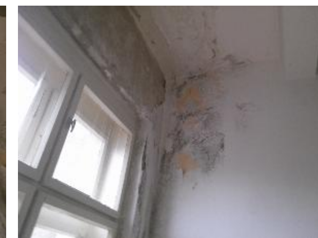
B. Pojava plijesni na zidu
