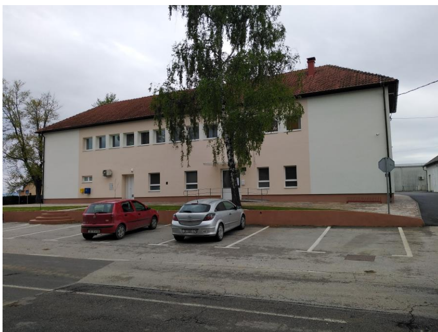
Slika 8. Završena energetska obnova zgrade [18]
