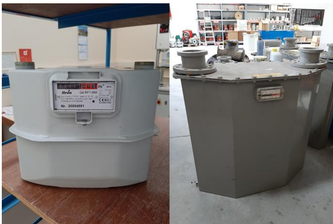
Slika 6. Plinomjeri na mijeh – G4 i G100 (fotografirano 3.8.2021.)
