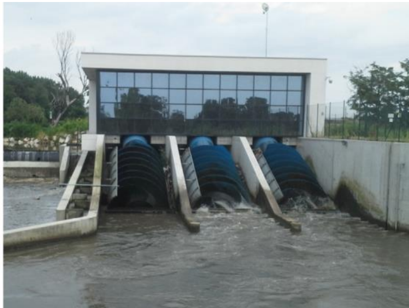
Slika 3.1. Tri paralelna Arhimedova vijka [10]
