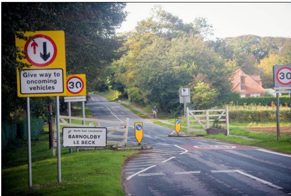
Slika 5.15. Ulazni infrastrukturni tretman za novi režim brzine
