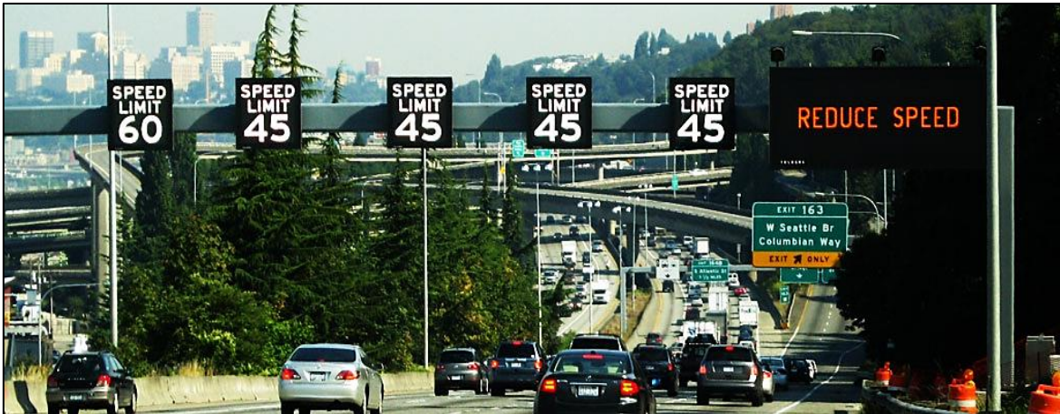
Slika 5.11. Promjenjivi prometni znakovi za reguliranje brzine vozila
