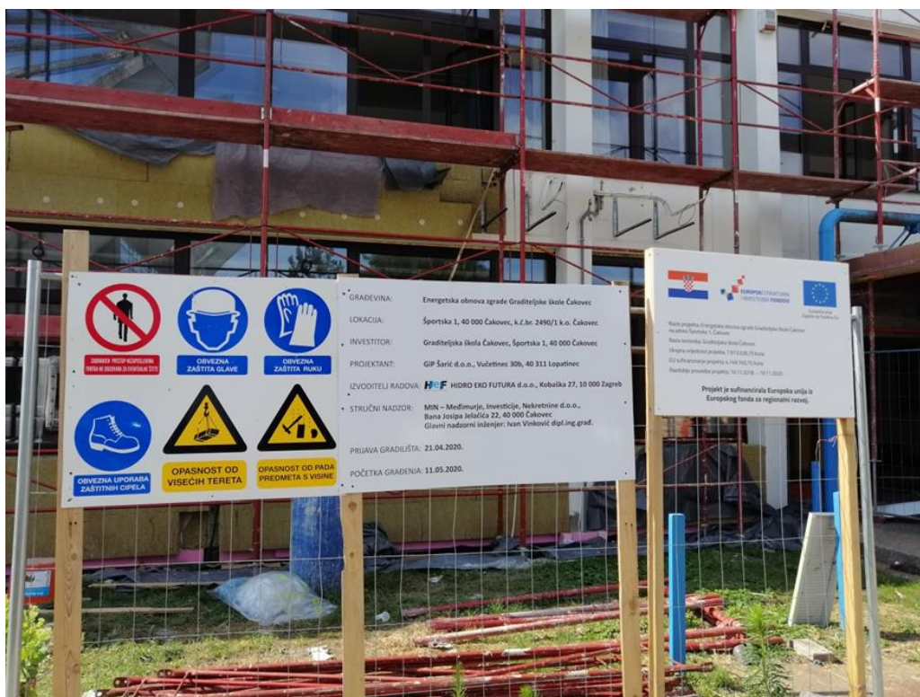
Slika 3. Ploča gradilišta sa znakovima zaštite na radu
