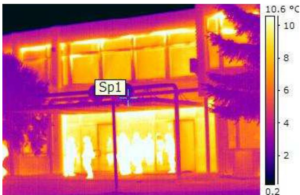
Slika 7. Termografija ulaznog prostora škole [9]
