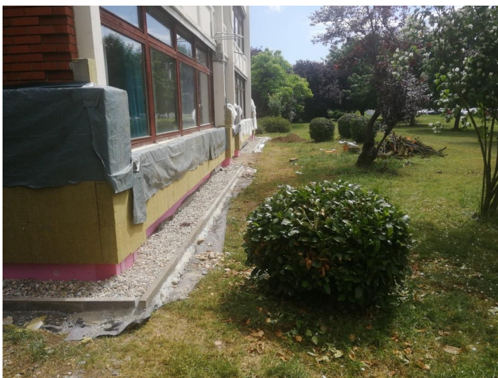
Slika 18. Toplinska izolacija južnog pročelja
