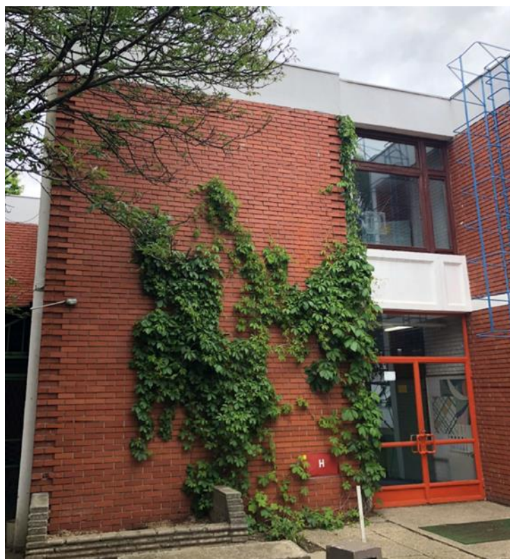
Slika 10. Zapadno pročelje škole [8]
