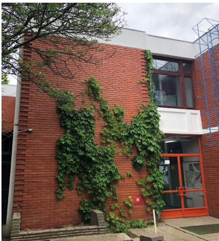
Slika 10. Zapadno pročelje škole [8]
