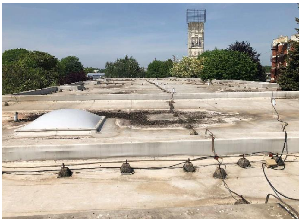
Slika 12. Ravni krov škole prije obnove [8]
