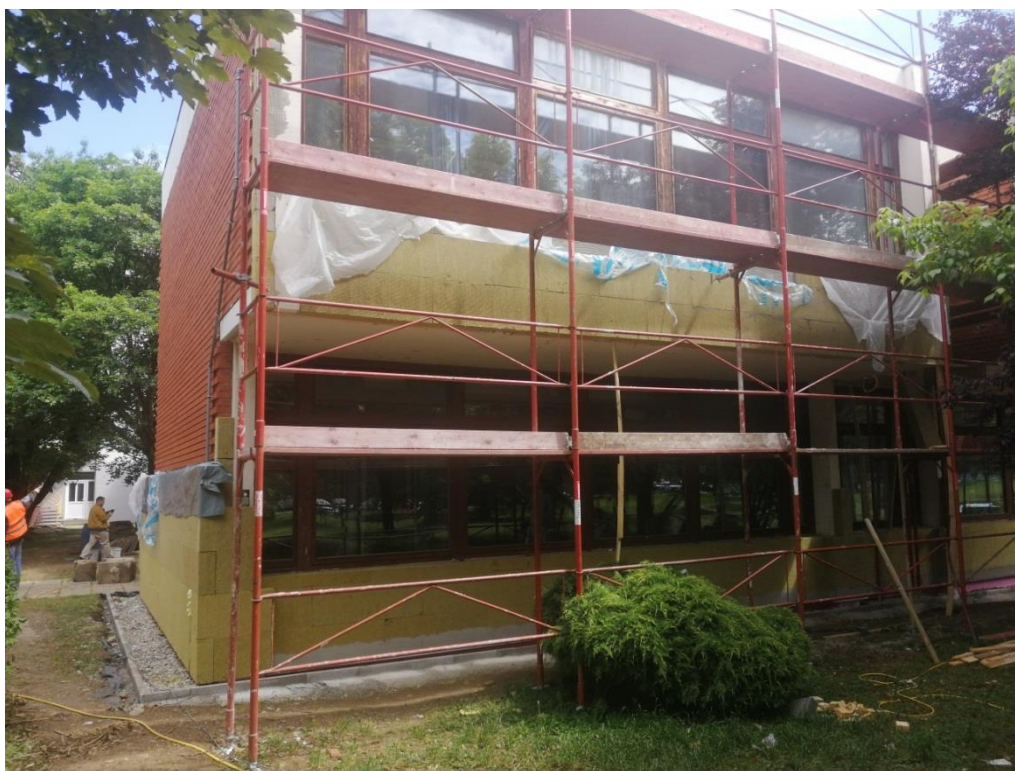
Slika 18. Toplinska izolacija južnog pročelja
