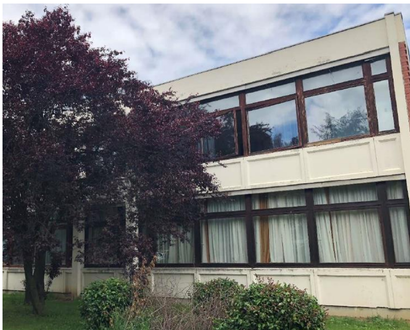
Slika 13. Stolarija južnog pročelja škole [8]
