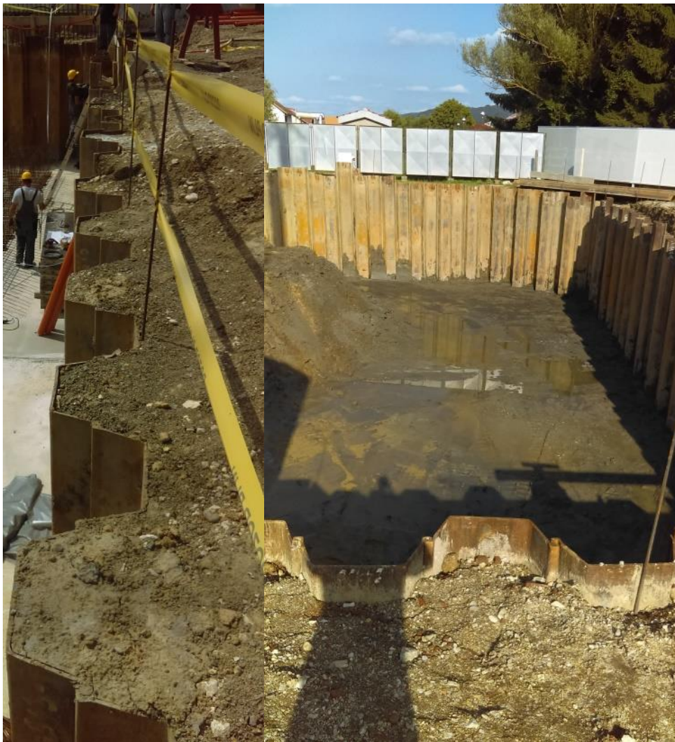
Slika 2.6. Zabijeno čelično žmurje
